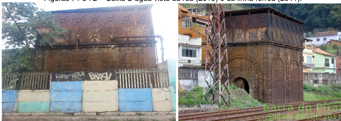
Figuras 71 e 72 – Caixa D'água vista da rua (2015) e da linha férrea (2011).
