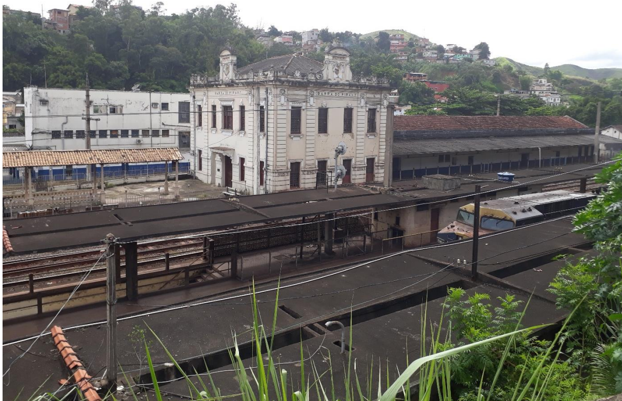
Figura 88 a 90 – Estação Central de Barra do Piraí e plataformas (2018).
