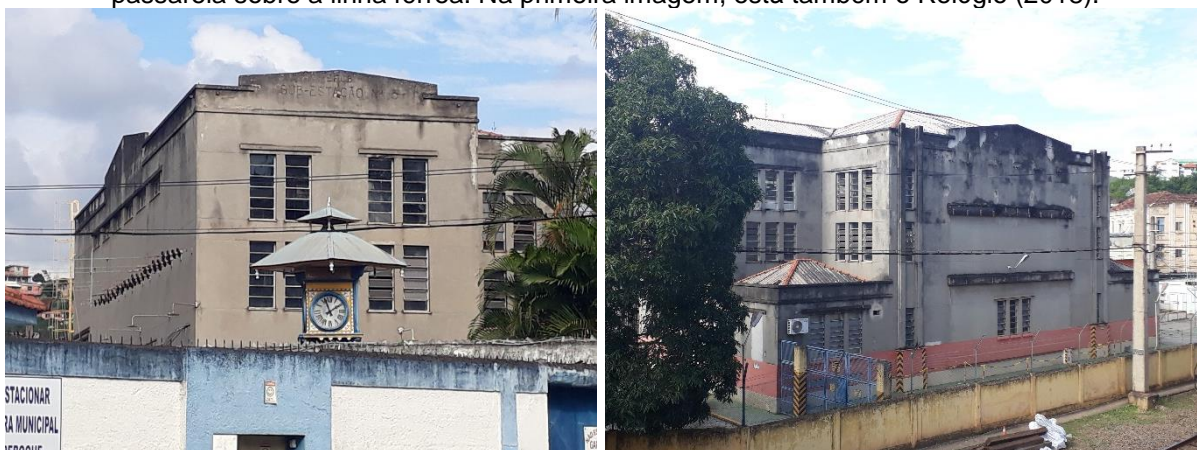
Figuras 111 e 112 – Subestação de Barra do Piraí vista da entrada da passagem de nível e da passarela sobre a linha férrea. Na primeira imagem, está também o Relógio (2018).
