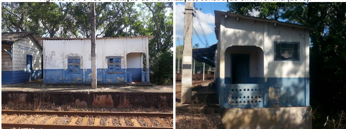
Figuras 134 e 135 – Estação de Pulverização, construção em alvenaria (2018).
