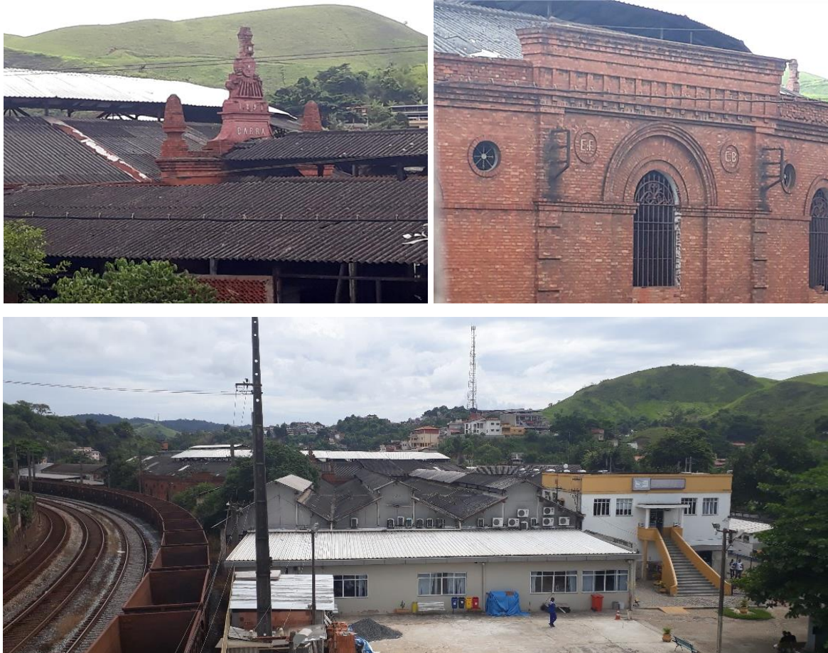
Figuras 73 a 75 – Detalhes da fachada principal e fachada lateral, anexos à fachada frontal (2018).
