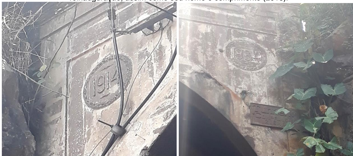
Figuras 53 e 54 – Detalhes da fachada do Túnel 14: Placas indicam datas de inauguração e reinauguração, assim como seu nome e comprimento (2018).
