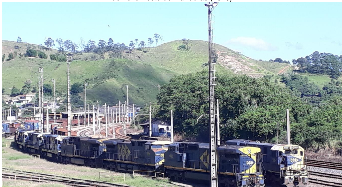
Figura 128 – Antigo Pátio de Pulverização, atual Pátio da Oficina de Vagões da MRS Logística visto do novo Posto de Manobras (2018).
