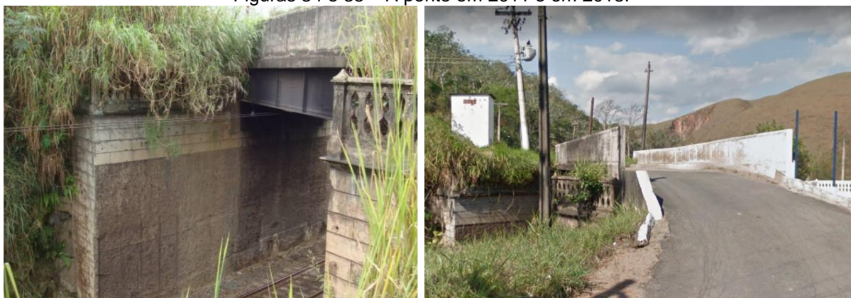
Figuras 34 e 35 – A ponte em 2011 e em 2018.
