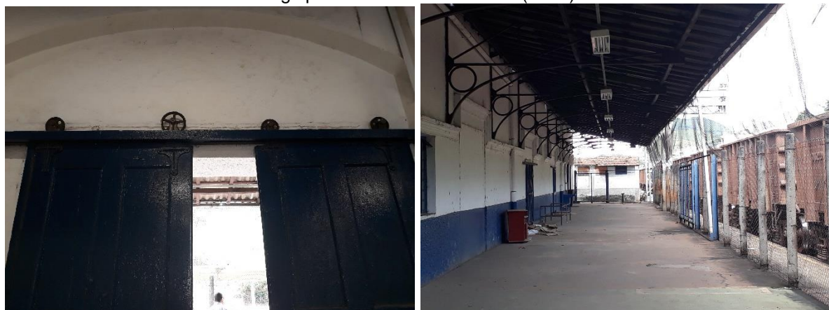
Figuras 103 e 104 – Uma das portas de correr do Galpão 1. Área externa que faz ligação com todos os galpões e com a linha férrea (2018).
