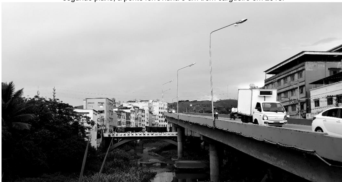
Figura 20 – Viaduto Faria Lima no centro de Barra do Piraí. Ao fundo duas pontes sobre o rio Piraí: em segundo plano, a ponte ferroviária e um trem cargueiro em 2018.
