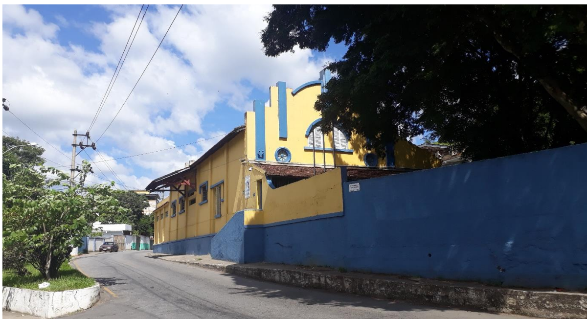
Figura 153 – Fachada voltada para a rua Antonio da Silva Brinco (2018).
