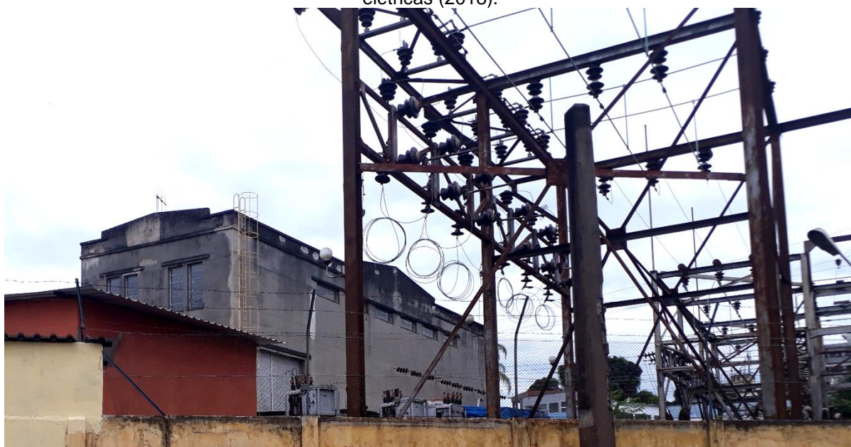
Figura 110 – Prédio da subestação visto da rua da Estação. Em primeiro plano, as instalações elétricas (2018).
