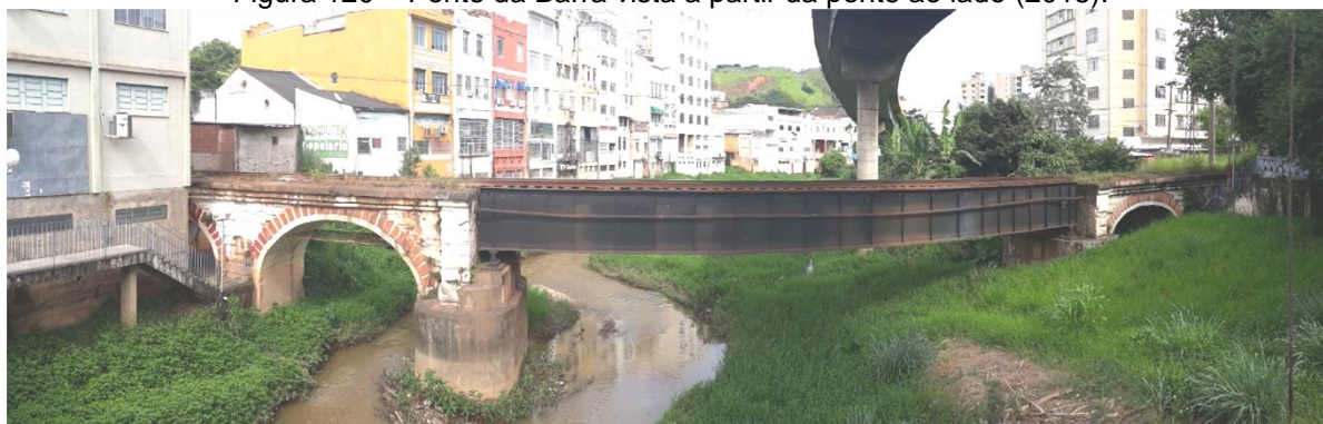
Figura 120 – Ponte da Barra vista a partir da ponte ao lado (2018).
