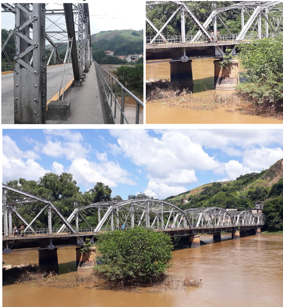
Figuras 145 a 147 – Ponte Metálica. (2018).
