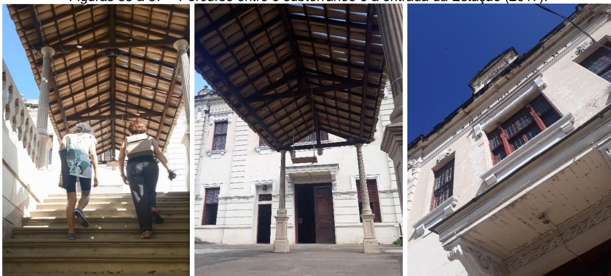
Figuras 85 a 87 – Percurso entre o subterrâneo e a entrada da Estação (2017).
