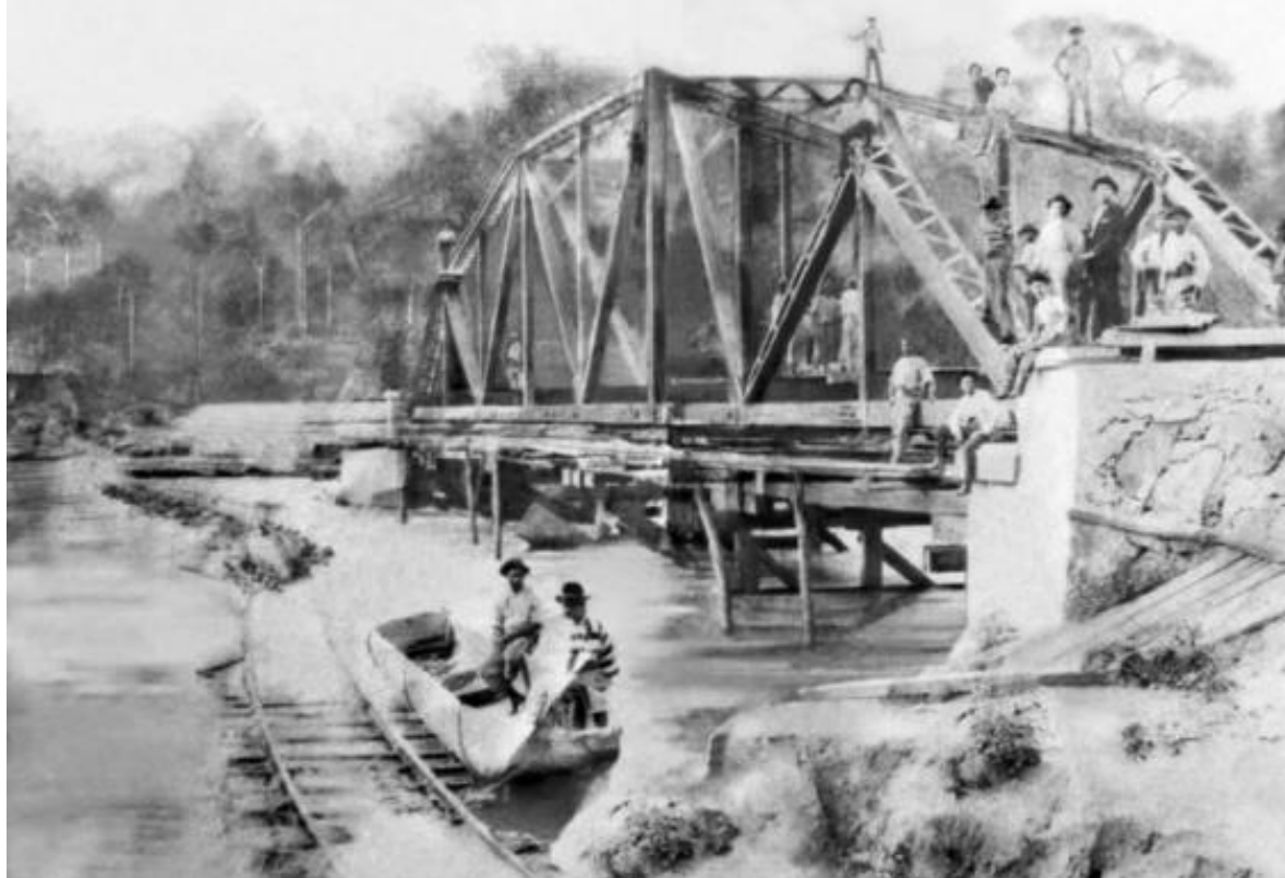
Figura 143 – Construção da Ponte Getúlio Vargas após o desabamento da ponte de madeira (1900).
