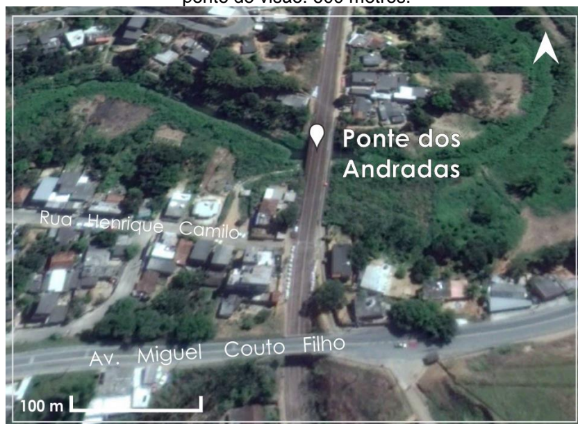
Figura 56 – Localização da Ponte dos Andradas. Imagem capturada em outubro de 2017. Altitude do ponto de visão: 600 metros.
