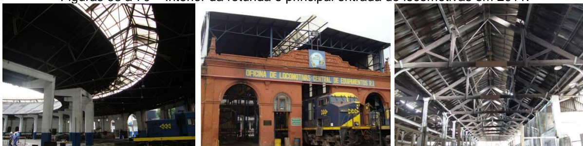
Figuras 68 a 70 – Interior da rotunda e principal entrada de locomotivas em 2011.
