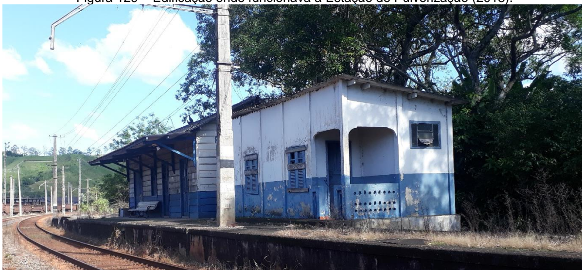
Figura 129 – Edificação onde funcionava a Estação de Pulverização (2018).
