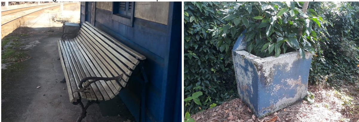
Figuras 130 e 131 – Banco acoplado à fachada e tanque de concreto (2018).
