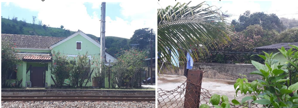
Figuras 38 e 39 – Casa do Chefe da Estação e plataforma no quintal em 2018.
