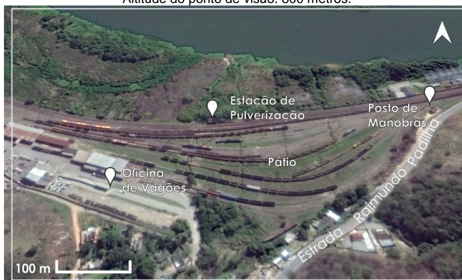
Figura 125 – Localização da Estação e Pátio de Pulverização. Imagem capturada em outubro e 2017. Altitude do ponto de visão: 800 metros.
