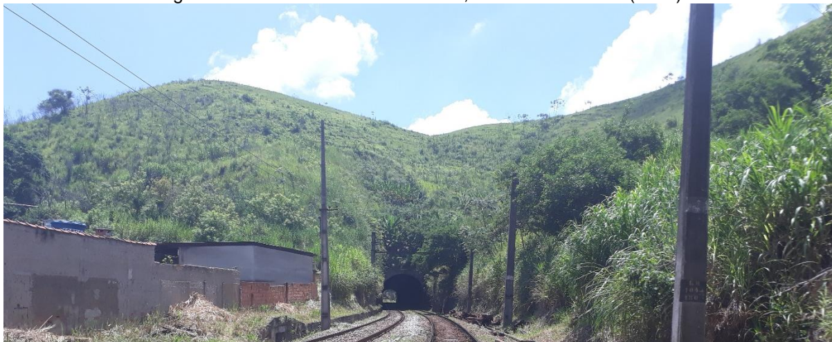
Figura 51 – Embocadura do Túnel 14, bairro Carbocálcio (2018).
