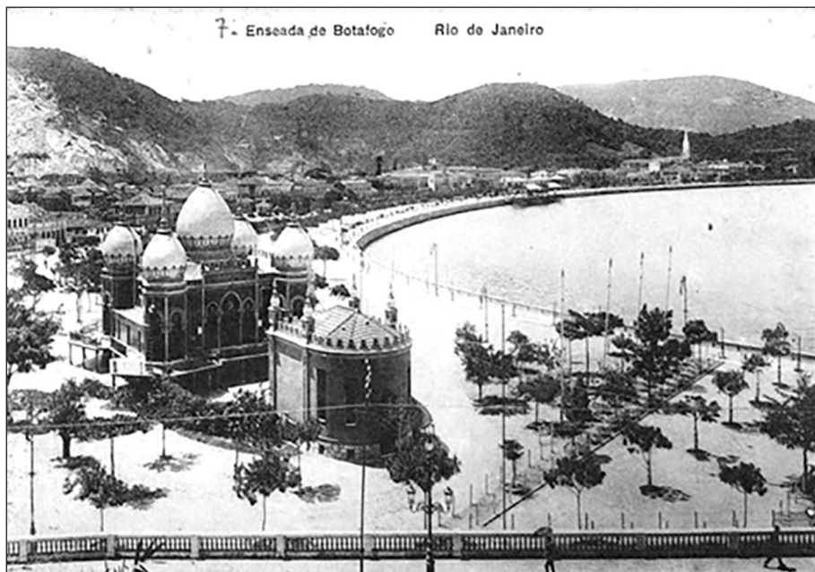
Figura 4 – Centro Cultural Pavilhão Mourisco
