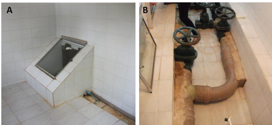
Figura 17: Edificações nas nascentes 6 (A) e 7 (B) da Serra de São José.
