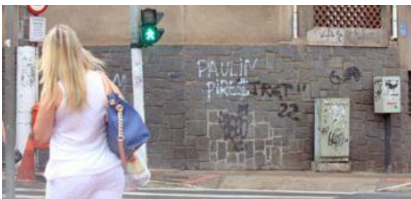
Prédio na esquina da Benjamin CONSTANT
