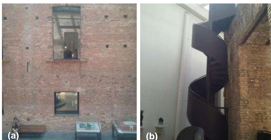
Figura 4: O objeto minimalista e a musealização: a transformação da função original do objeto através de intervenções contemporâneas – (a) e (b) interior da Pinacoteca de São Paulo de Paulo.
