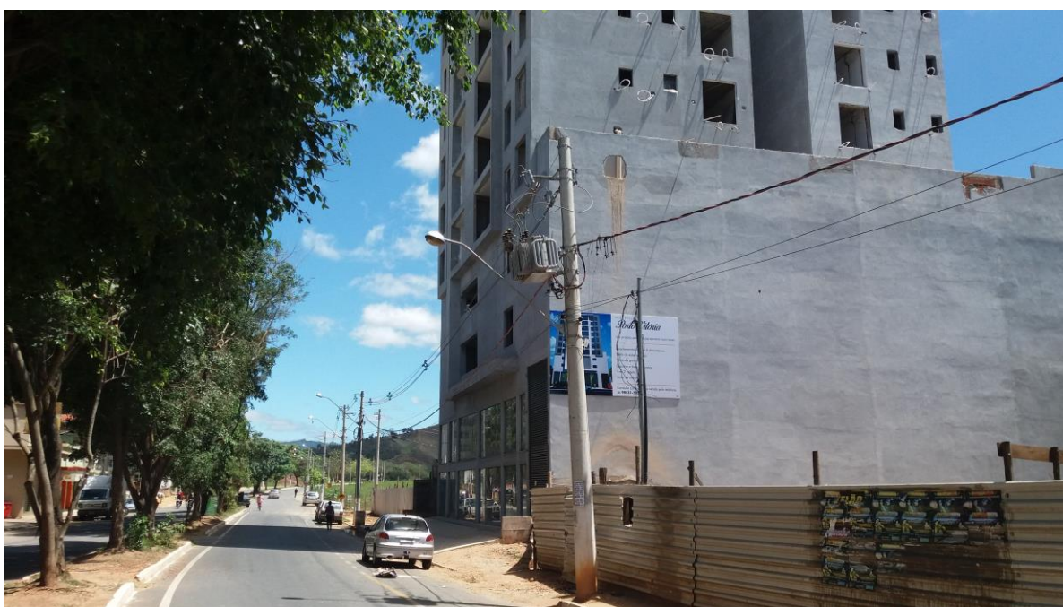
(Construção Residencial Porto Vitória - Foto 11/2017, acervo pessoal)
