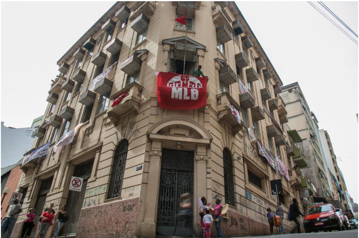
Imagem 11: Edifício no centro de Porto Alegre que abriga cerca de 300 pessoas. Fonte: http://www.sul21.com.br/wp-content/uploads/2015/11/20151116-jornal-sul21-4051cf161115-09-1024x683.jpg
