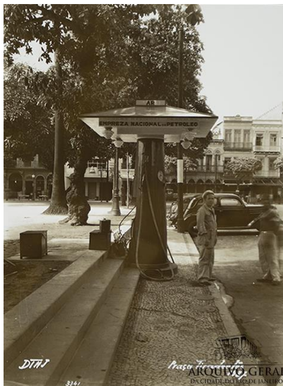
Figura 69: Bomba de gasolina instalada na praça, em 1969.
