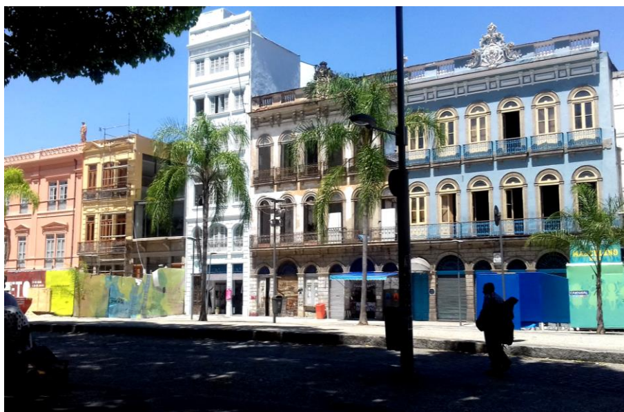
Figura 94: O edifício azul, à direita, abriga a Associação Centro Cultural Estudantina.
