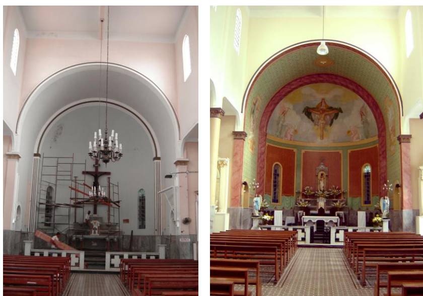
Imagens 10 e 11. Retirada de camadas de tinta e resgate de pinturas parietais na Igreja de S. Sebastião, Três Rios (RJ). Fonte: http://adilson-nascimento.blogspot.com.br/2010/04/restauracao-em-andamento.html . Acesso: 03 nov. 2016.
