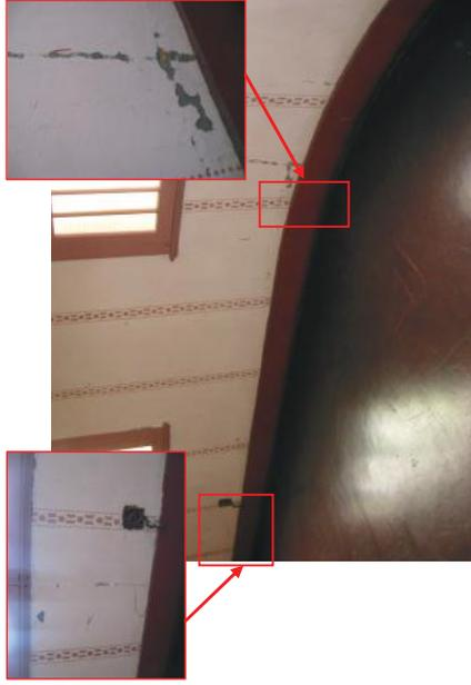
Figura 4.45 – Patologias causadas pela fixação de adesivos e pregos.
