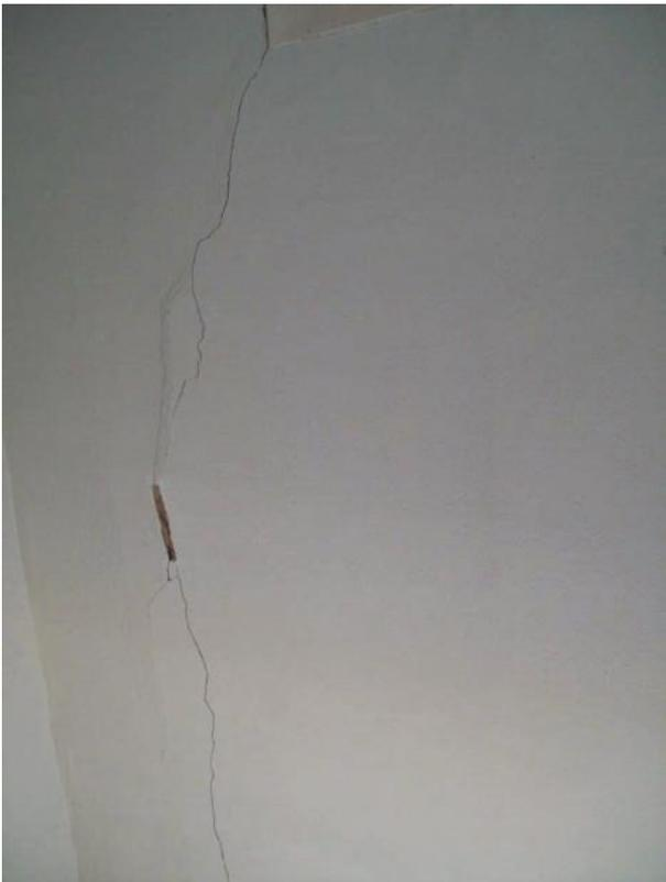
Figura II-5 - Fissura pela atuação de sobrecarga do telhado
