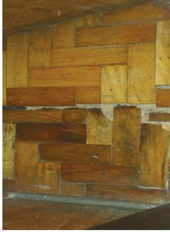
Foto 4.3 – Piso danificado no Acesso aos Depósitos.
