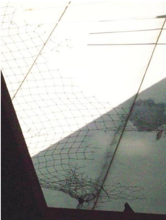
Figura IX-1 – Gradil de fibra têxtil sintética danificado na Quadra Poliesportiva
