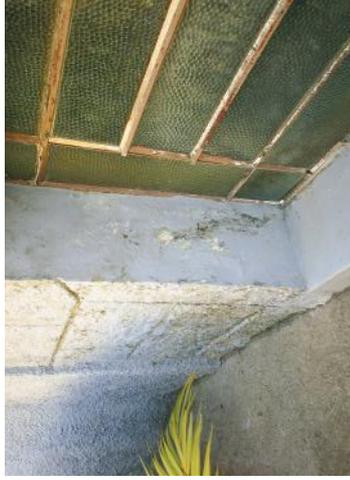
Foto 4.39 – Pintura danificada no Basculante do Porão.
