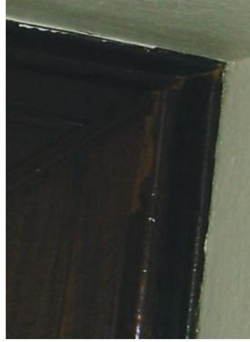
Foto 4.25 - Deterioração por insetos (Cupim) no Banheiro do Segundo Pavimento.
