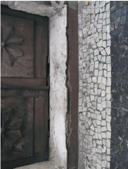
Figura V-4 - Porta e soleira deteriorada na fachada da Rio Branco
