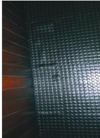
Foto 4.7 – Perca de aderência no revestimento de borracha da Plateia.
