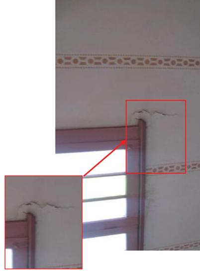
Figura 4.35 – Exemplo de fissura devido à falta ou deficiência de contra-verga.
