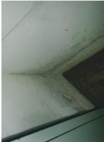
Foto 4.33 – Rodapé degradado no Depósito 4.
