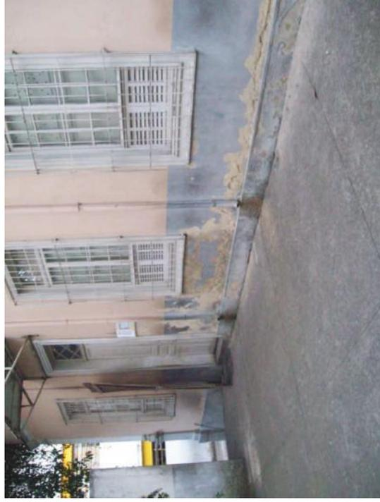
Figura I-2 - Deterioração do revestimento da fachada lateral (Fachada I)
