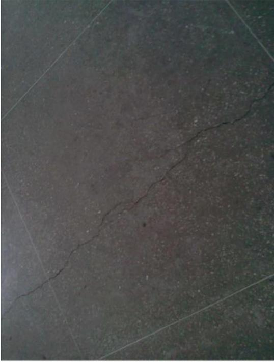
Figura VI-7 - Piso de granilite deteriorado no Auditório
