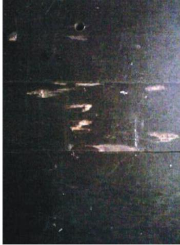
Foto 4.8 – Deterioração do piso do palco.
