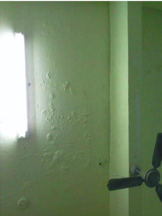
Figura III-3 - Empolamento na laje da Sala 24
