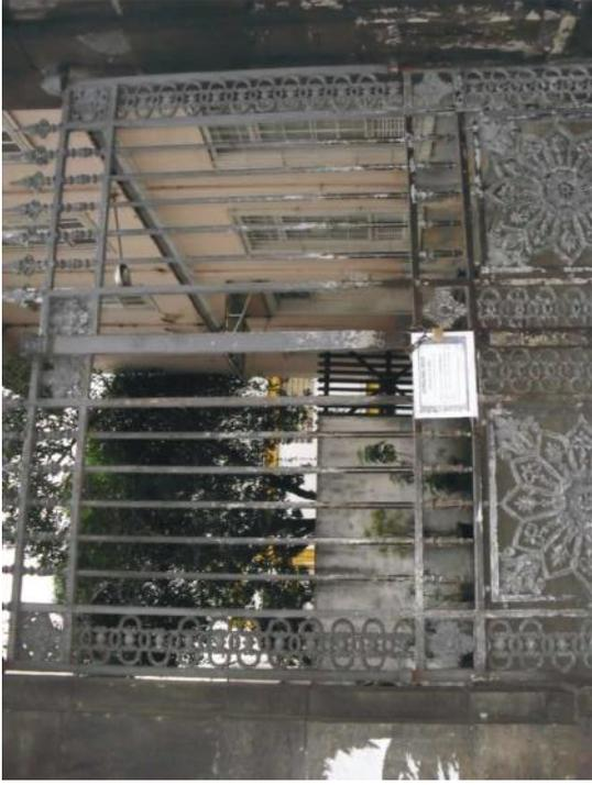
Figura I-5 - Pintura deteriorada das grades
