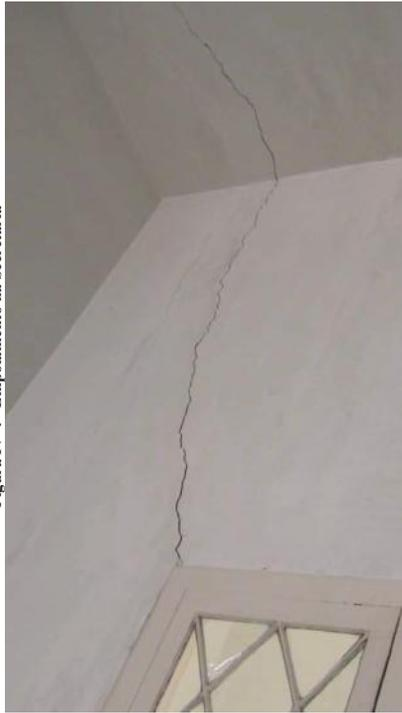
Figura IV-5 - Fissura devido à sobrecarga (Sala 9)
