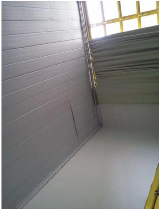
Figura III-4 - Forro de PVC danificado Auditório
