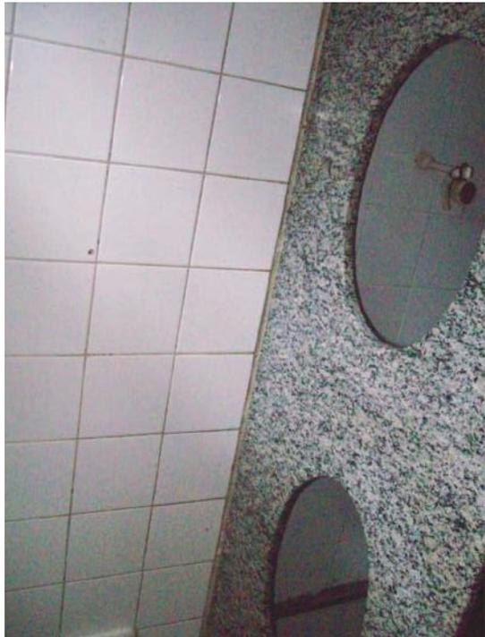
Figura VII-4 - Ausências das cubas cerâmicas do Banheiro Masculino do Prédio Anexo (1º Pavimento)
