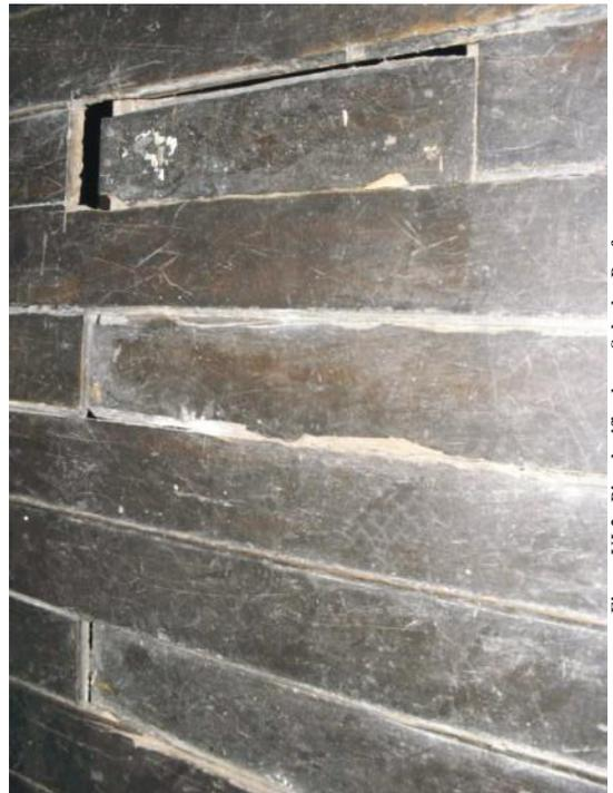
Figura VI-2 - Piso danificado na Sala dos Professores
