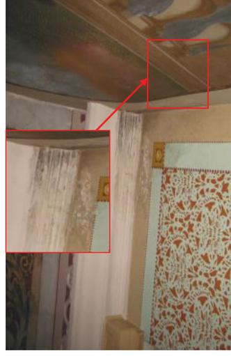
Figura 4.51 – Manchas de umidade causadas por vazamentos da calha do telhado.
