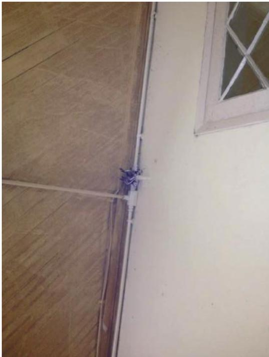
Figura VIII-1 - Caixa de passagem com fiação exposta na Sala 1
