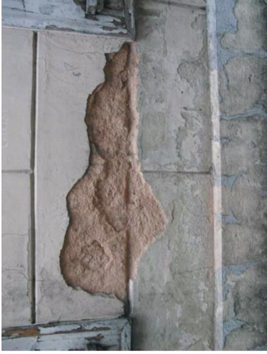
Figura I-1 – Deterioração da pintura e descolamento do reboco na fachada da Avenida Rio Branco
