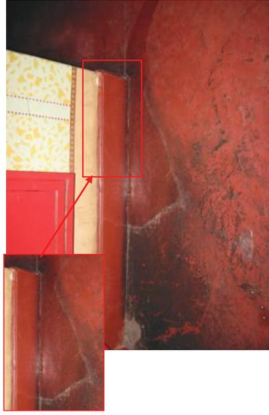
Figura 4.4 – Danos causados pela percolação de água nos materiais de construção, porta de acesso à galeria Azarias Vilela.
