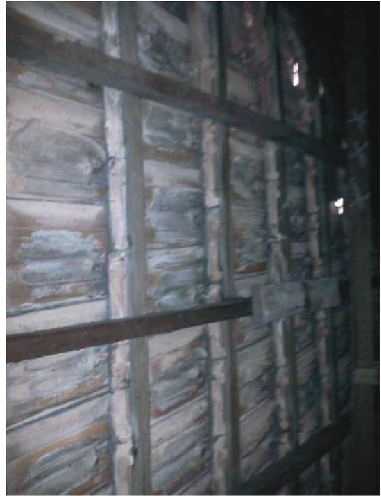
Figura II-2 - Telhas deslocadas e remendo no madeiramento
