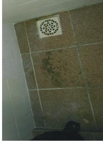
Foto 4.9 – Piso desgastado no revestimento cerâmico do Banheiro.
