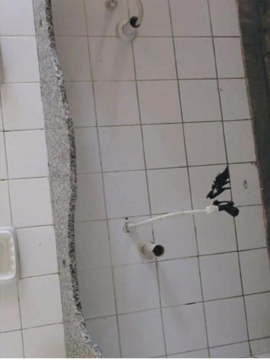
Figura VII-5 - Bancada quebrada e ausência de cuba cerâmica no Banheiro Feminino do Prédio Anexo (3º Pavimento)
