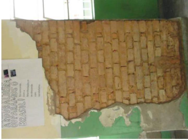
Figura IV-7 - Descolamento da argamassa de revestimento (Corredor)
