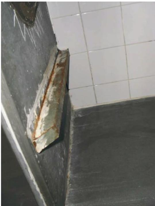
Figura VII-1 - Oxidação do suporte da bancada no Banheiro Feminino da Sala dos Professores
