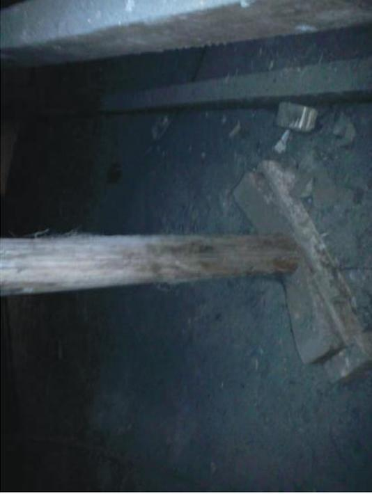
Figura II-3 - Utilização de escoras no madeiramento do telhado
