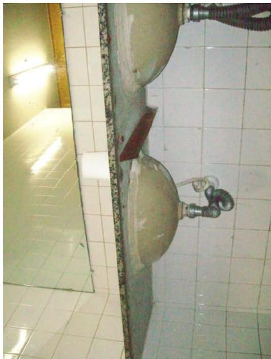
Figura VII-2 - Oxidação do suporte da bancada do Banheiro Feminino no Prédio Anexo (1º Pavimento)
