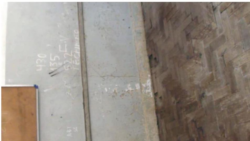
Figura VI-9 - Piso de tampo danificado na Sala 12
