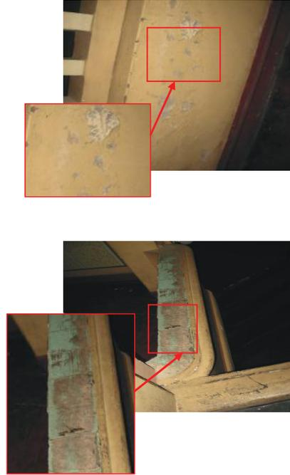
Figura 4.42 – Pintura descascando nos balcões, camarotes especiais e no fosso.
