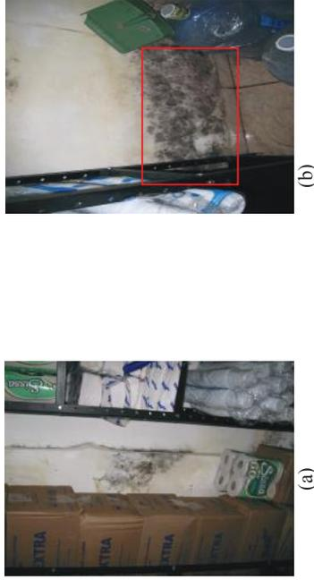
Figura 4.49 – Exemplos de patologias causadas por umidade no depósito de limpeza.
