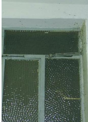
Foto 4.43 – Puxador quebrado no Depósito 3.
