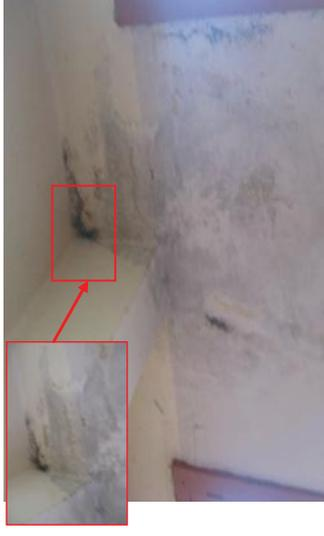
Figura 4.46 – Patologias causadas pelo vazamento no sistema de impermeabilização.
