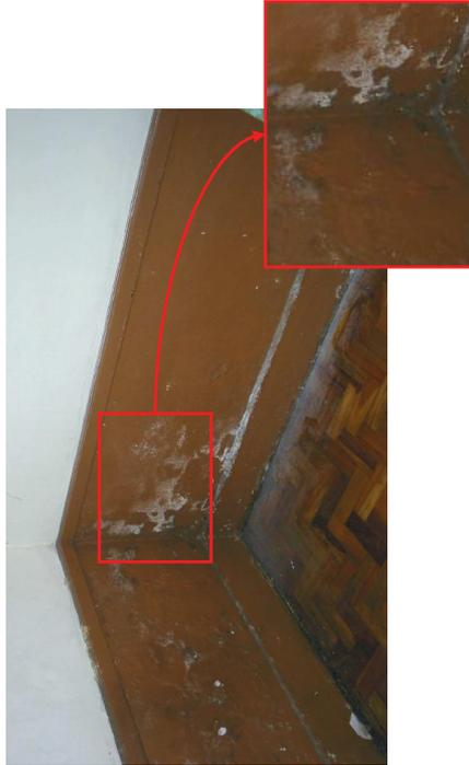
Foto 4.20 – Vazamento hidráulico na Sala do Coral.
