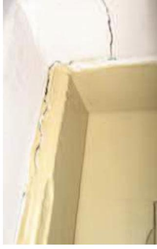
Figura 4.56 – Sobrecarga junto ao vão de abertura de porta.
