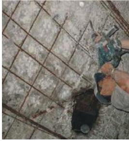
Procedimento: recomenda-se a escarificação do concreto; remoção completa do óxido de ferro com escova de aço e lixa; aplicação, sobre a armadura e o concreto escarificado, de graute (SIKA GRAUT AC, da marca SIKA).
