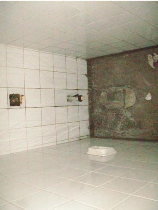
Figura VII-3 - Ausência da bacia sanitária no Banheiro Masculino do Prédio Anexo (1º Pavimento)
