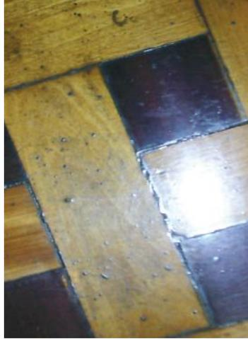
Foto 4.1 – Vista útil do sinteco comprometida na Sala de Espera.
