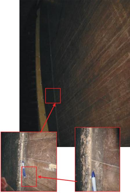
Figura 4.54 – Detalhe do desnível causado pelo recalque do piso do palco.
