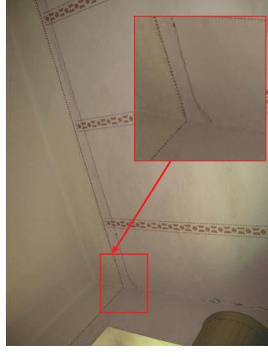
Figura 4.37 – Trinca no encontro da laje/viga com a alvenaria.
