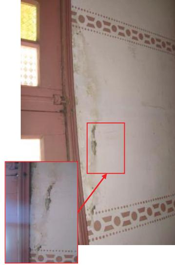
Figura 4.44 – Patologias causadas pela entrada de água pela janela.
