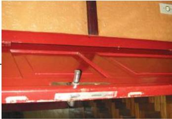
Foto 4.37 – Porta desgastada e fechadura quebrada na Sala de Aula do Segundo Pavimento.
