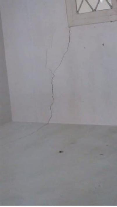
Figura IV-6 - Fissura devido a sobrecarga (Sala 10)
