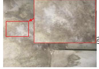
Figura 4.52 – Machas/ estufamento da pintura causadas por vazamentos hidráulicos.
