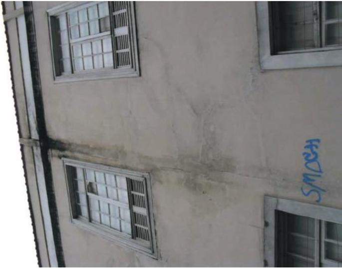
Figura I-3 - Pichações e deterioração do revestimento da fachada por umidade e vazamentos do telhado
