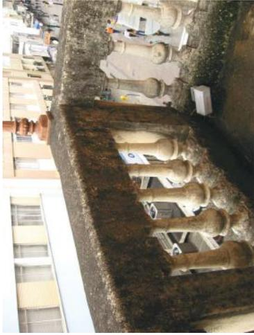
Figura 4.11 – Umidade na fachada.
