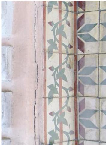
Foto 4.6 – Deterioração do piso da Sacada.
