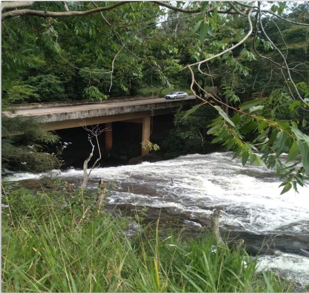
Figura 18. Ponte sobre o ribeirão Jacutinga
