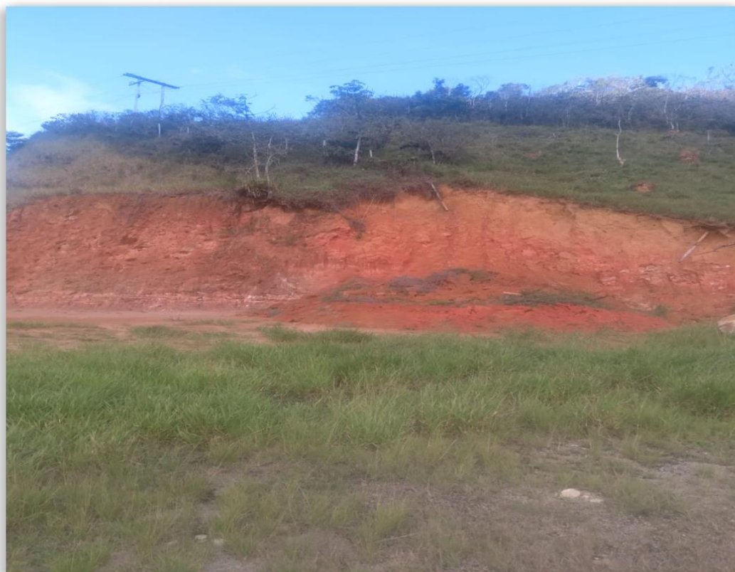
Figura 35. Corte em talude na média bacia
