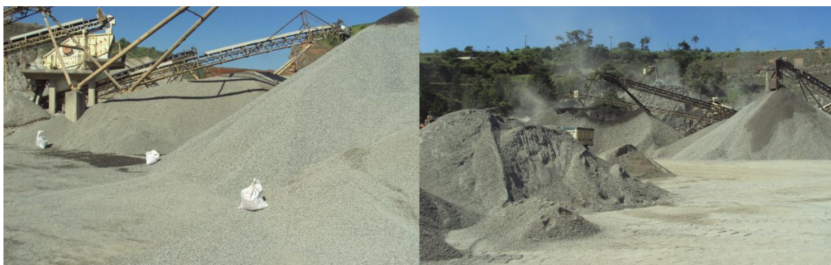
Figura 34– Britadores de Mandíbula, esteiras para o carregamento dos materiais e pilhas de materiais
