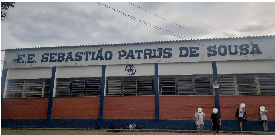
Figura 1 – Fachada da EESPS
