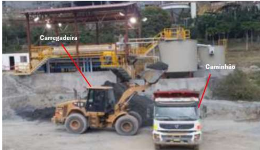
Figura 11 - Transporte do rejeito utilizando pá carregadeira e caminhão basculante
