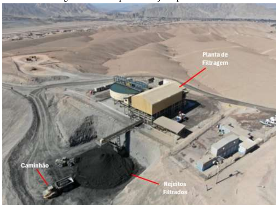
Figura 12 - Transporte do rejeito por caminhão
