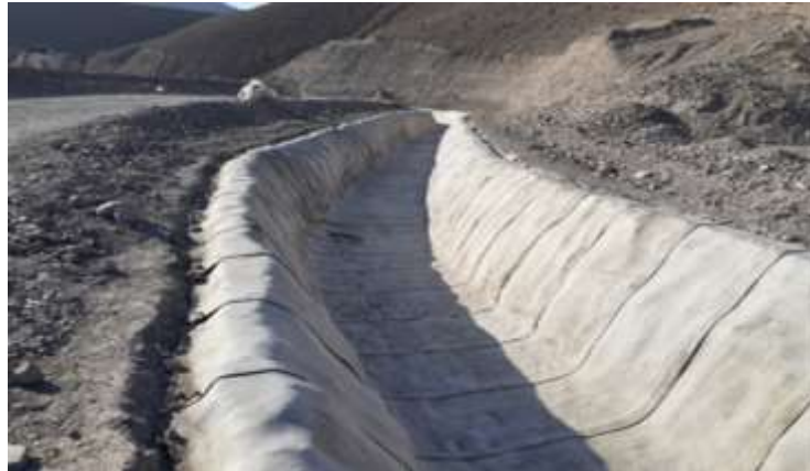
Figura 22 - Exemplo de uma vala perimetral
