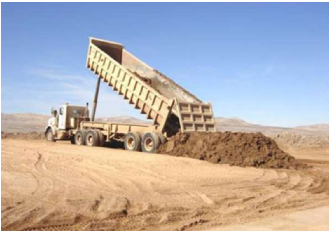
Figura 17 – Caminhão despejando os rejeitos na área do depósito
