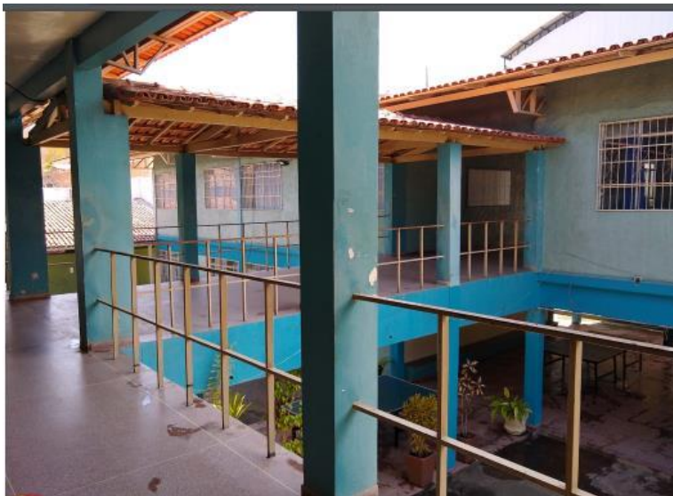
Figura 3 - Vista da ala superior da escola
