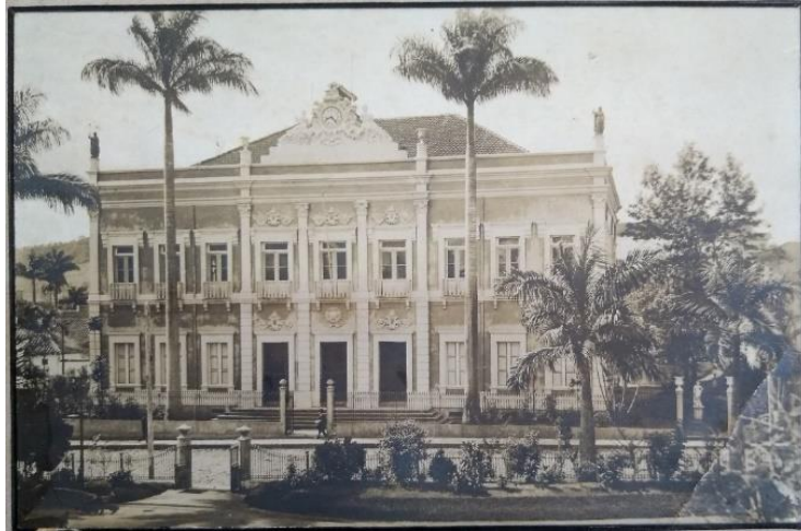
Figura 5 - Fórum Barbosa Lima, localizado ao lado do Parque Halfeld, em Juiz de Fora (MG).
