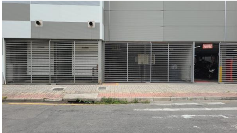
Figura 2: Imagem dos geradores de energia
