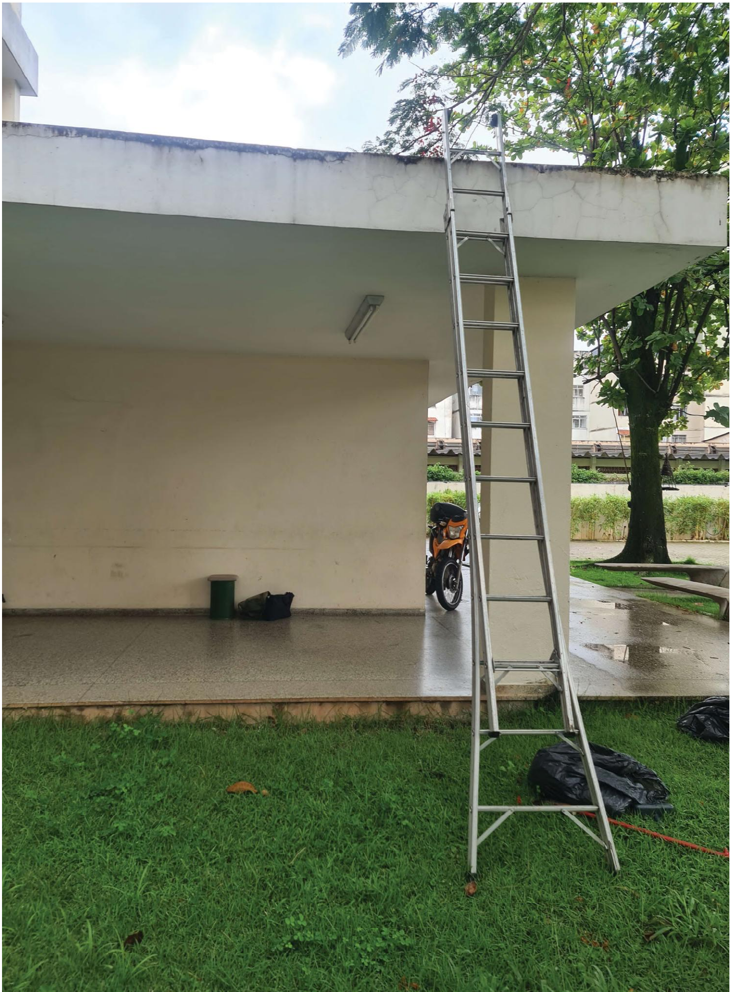
Uma escada de verdade dando acesso à laje no jardim do Mamm.
