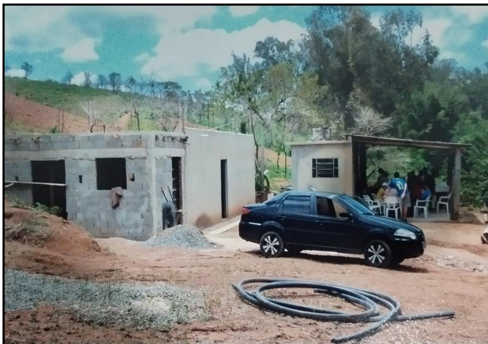
Figura 7 - Construção da Sede da AAMA (2008).
