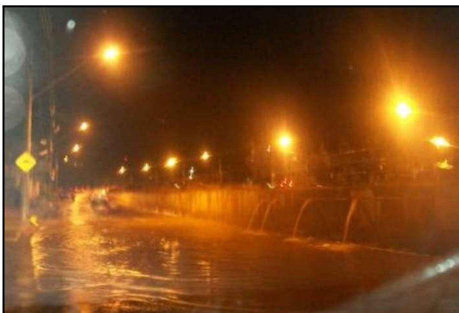
Figura 33 - Transbordamento da galeria do Córrego São Pedro e lançamento de esgoto na Av. Pedro Henrique Krambeck
