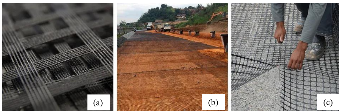
Figura 1 – Detalhes de uma geogrelha
