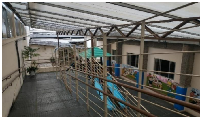
Figura 4 – Imagem da rampa vista de cima
