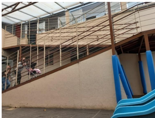
Figura 3 – Imagem da rampa que leva às salas de atividades
