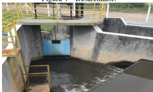
Figura 4 – Desarenador.
