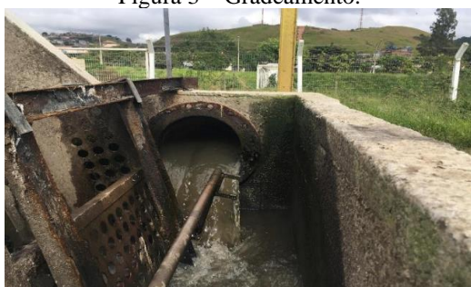
Figura 3 – Gradeamento.
