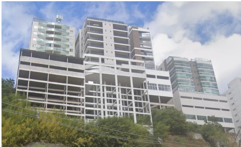
Figura 21 – Habitações multifamiliares em encostas
