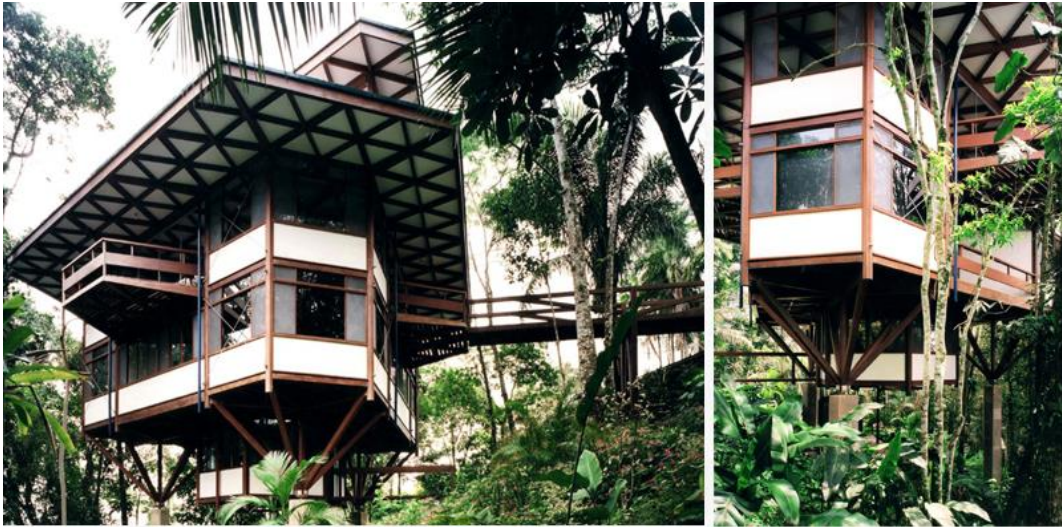
Figura 19 - Residência em Tijucopava
