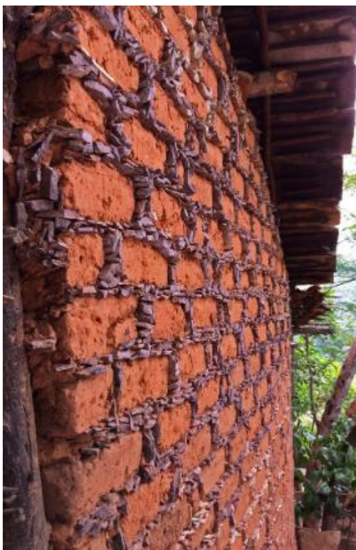
Figura 24: Técnica de parede de adobe, com cascos de ardósia
