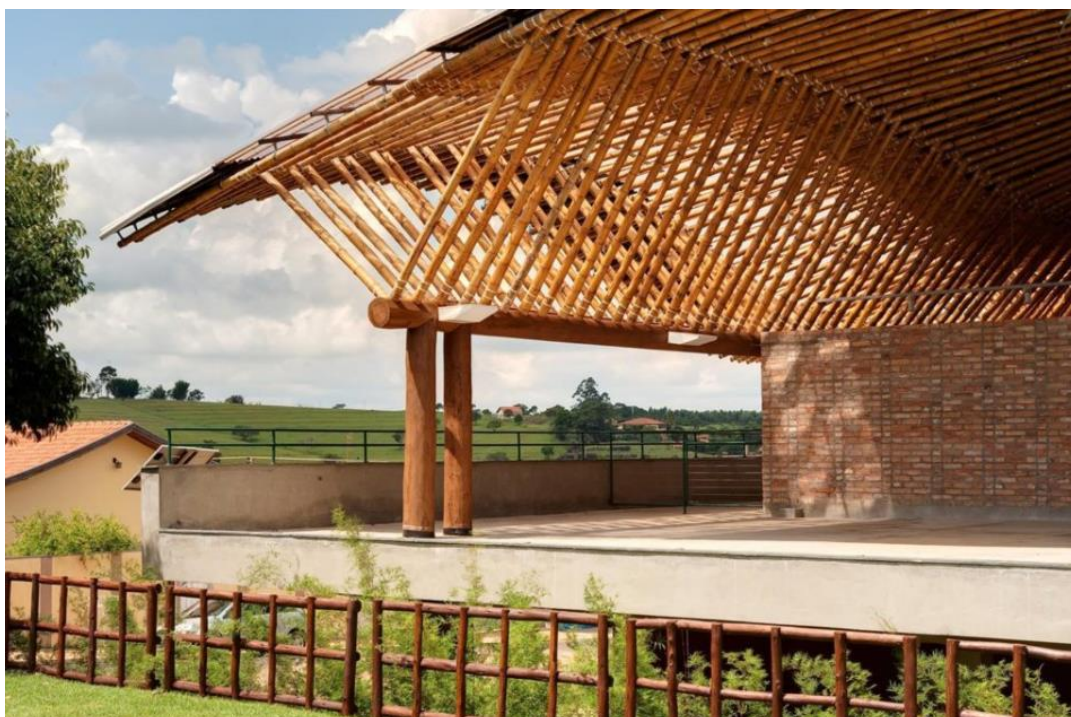
Figura 06: Edifício Centro de Cultura Max Feffer, SP: Cobertura de Bambu e Parede de Tijolo Ecológico.
