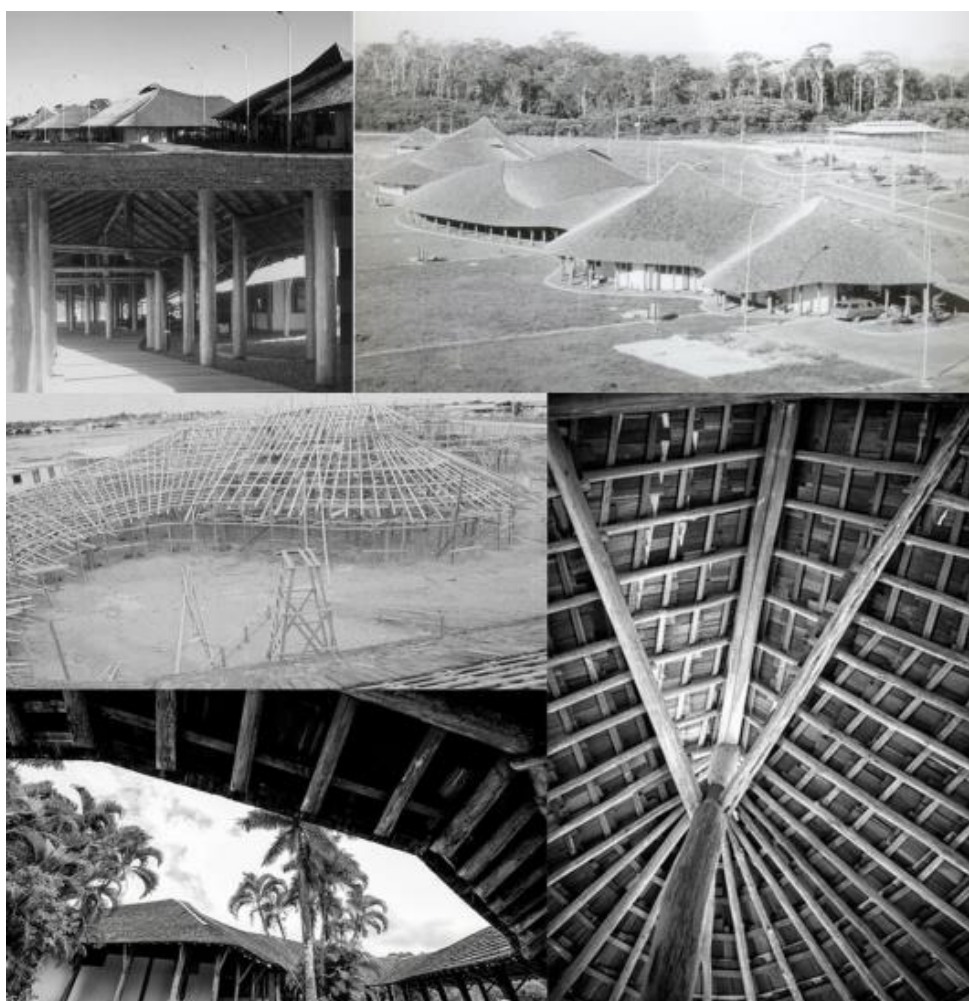
Figura 17: Centro de Proteção Ambiental de Balbina, 1988.
