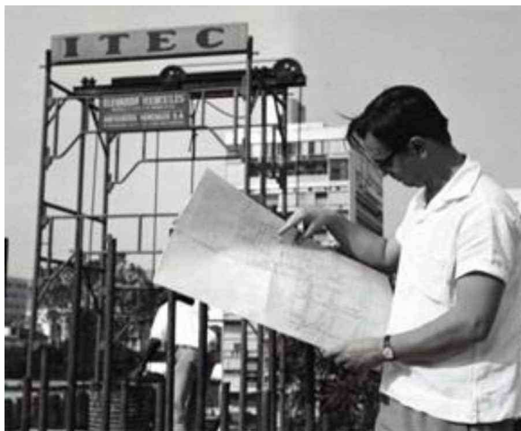
Figura 6 – Itamar analisando uma planta e ao fundo um letreiro da ITEC e o Edifício Clube Juiz de Fora
