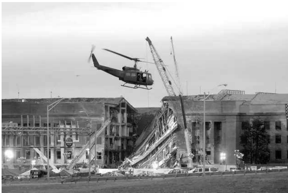
Figura 7 - Pentágono após ocorrência o colapso progressivo
