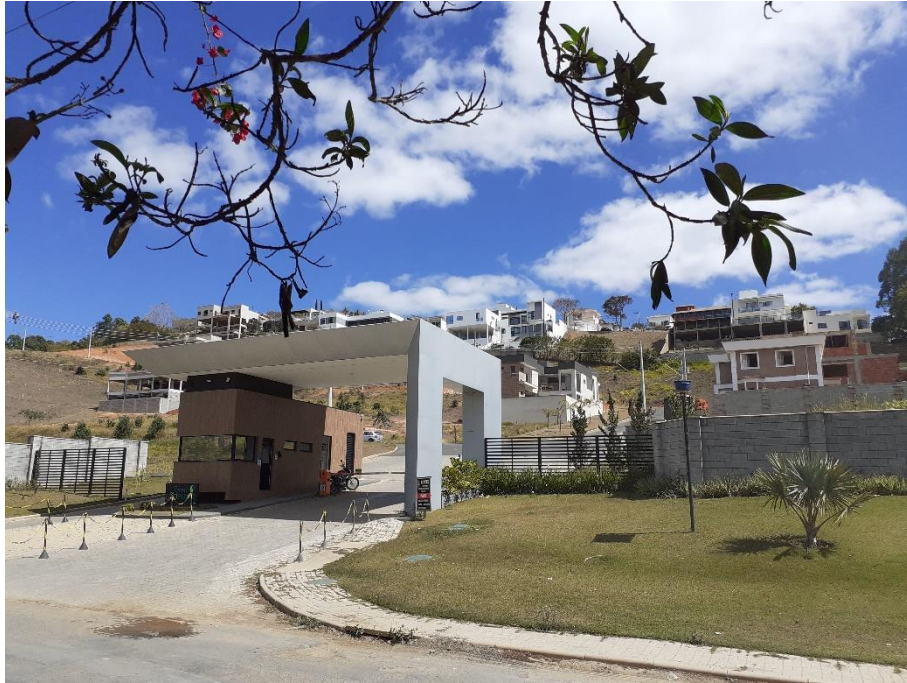
Figura 58 – Acesso condomínio Reserva de São Pedro
