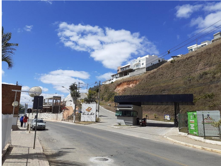
Figura 57 – Condomínio Via do Sol e edifício comercial em construção
