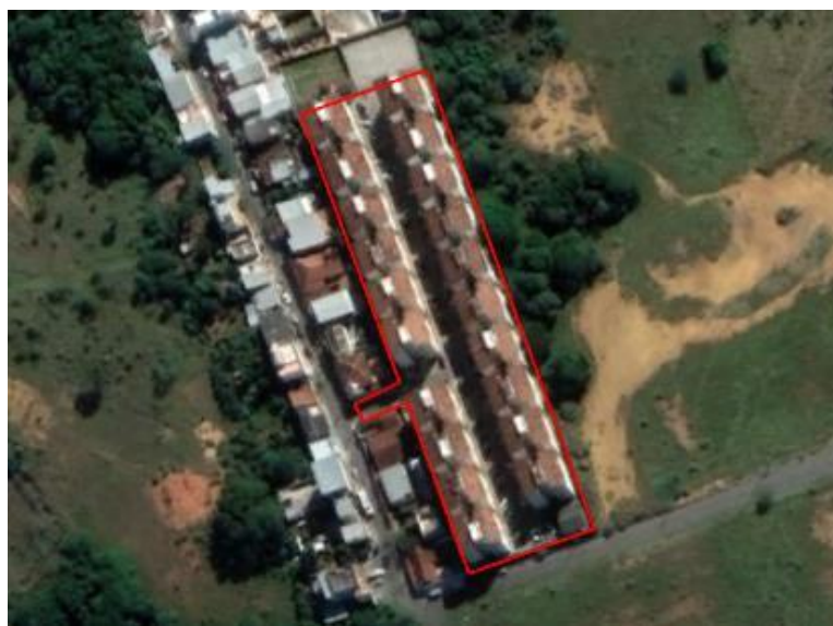
Figura 17 – Imagem aérea do condomínio Residencial Colinas de São Pedro
