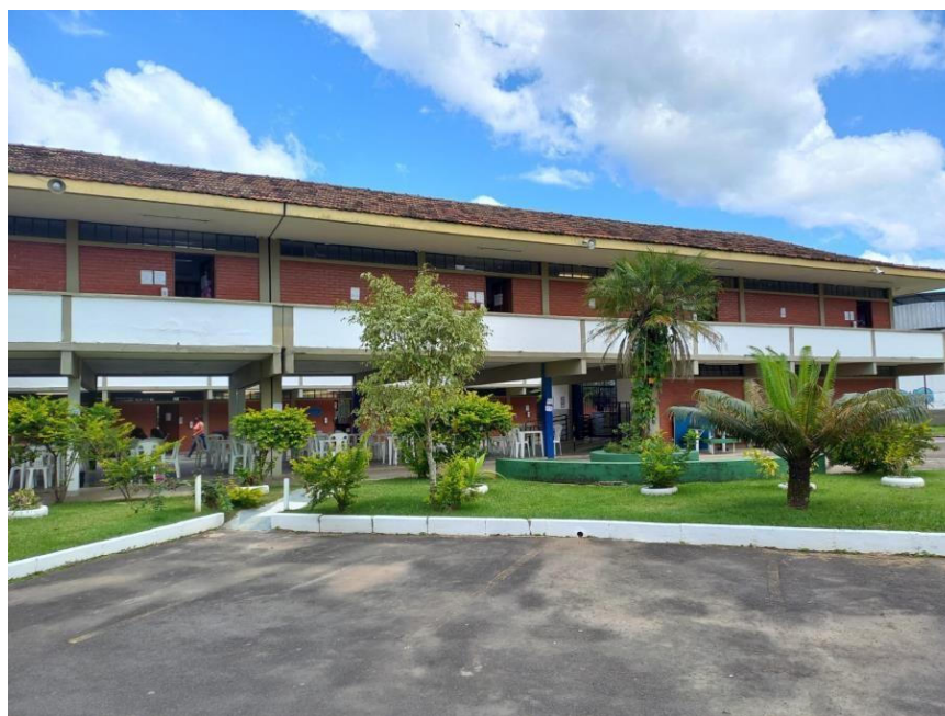
Figura 2 – Fachada da escola
