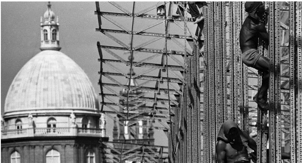
Figura 09 – Montagem das arquibancadas na Avenida Presidente Vargas em 1973
