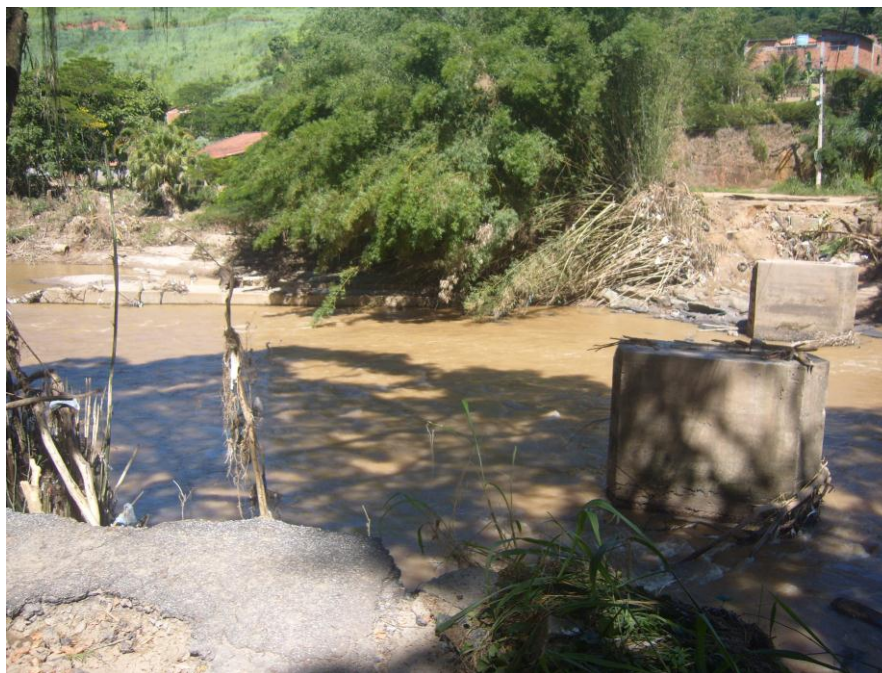
Figura 4.44 – Ponte destruída, setor Julioca. Fonte: Foto cedida pela Prefeitura Municipal de Areal, 2012.
