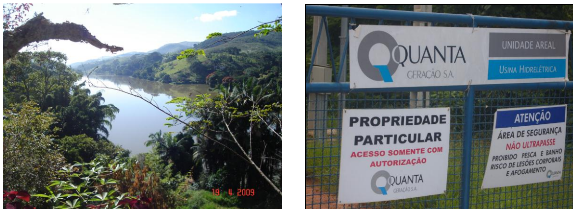
Figuras 4.17 e 4.18 – Reservatório e portão de entrada da barragem Morro Grande. Fonte: Fotos feitas pelo autor, 2009.
