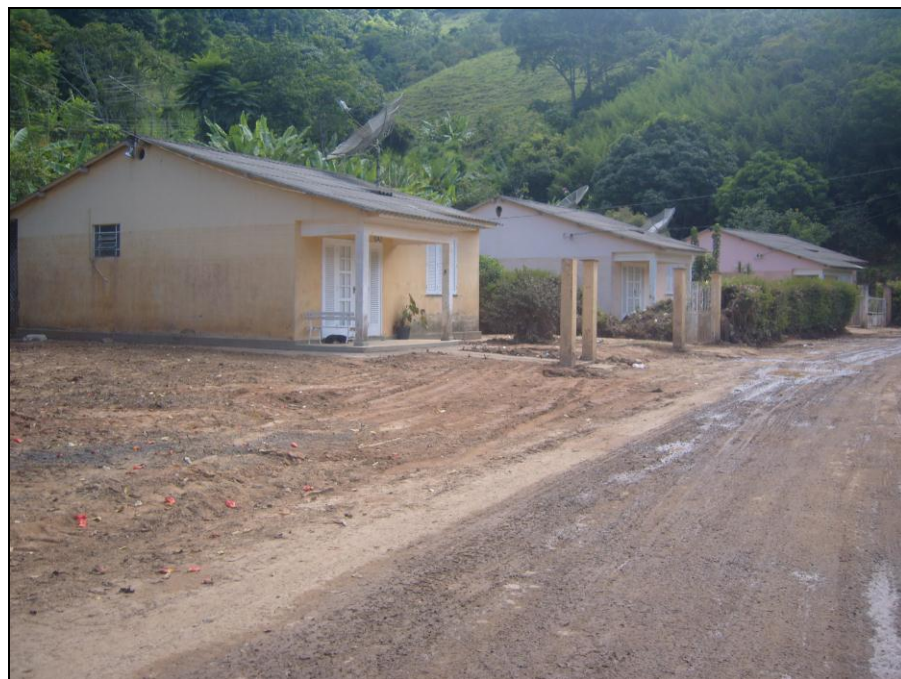
Figura 4.30 – Marca da altura da inundação no setor Morro Grande. Fonte: Foto cedida pela Prefeitura Municipal de Areal, 2012.
