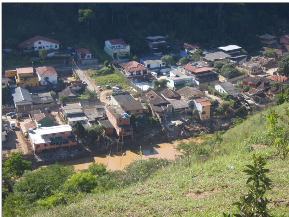
Figura 4.45 – Área marginal ao rio onde se deu grande capacidade de arrasto no setor Afonsina. Fonte: Foto cedida pela Prefeitura Municipal de Areal, 2012.
