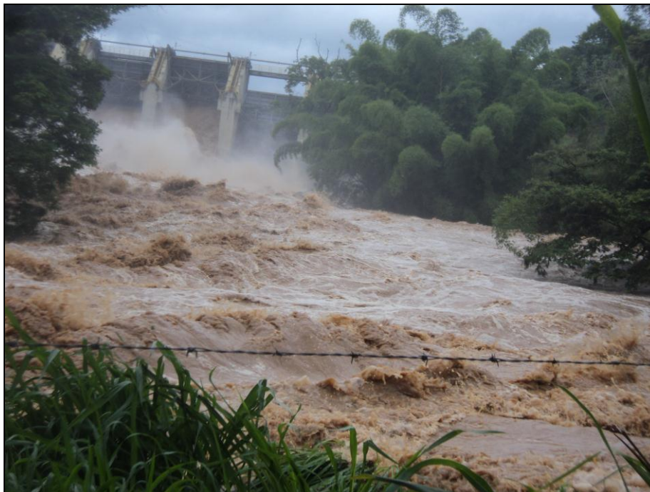
Figura 4.27 – Barragem Morro Grande, Setor Amazonas, manhã do dia 12/01/2011. (Obs.: a comporta da direita apresentou problemas de operação). Fonte: Foto cedida pela Prefeitura Municipal de Areal, 2013.
