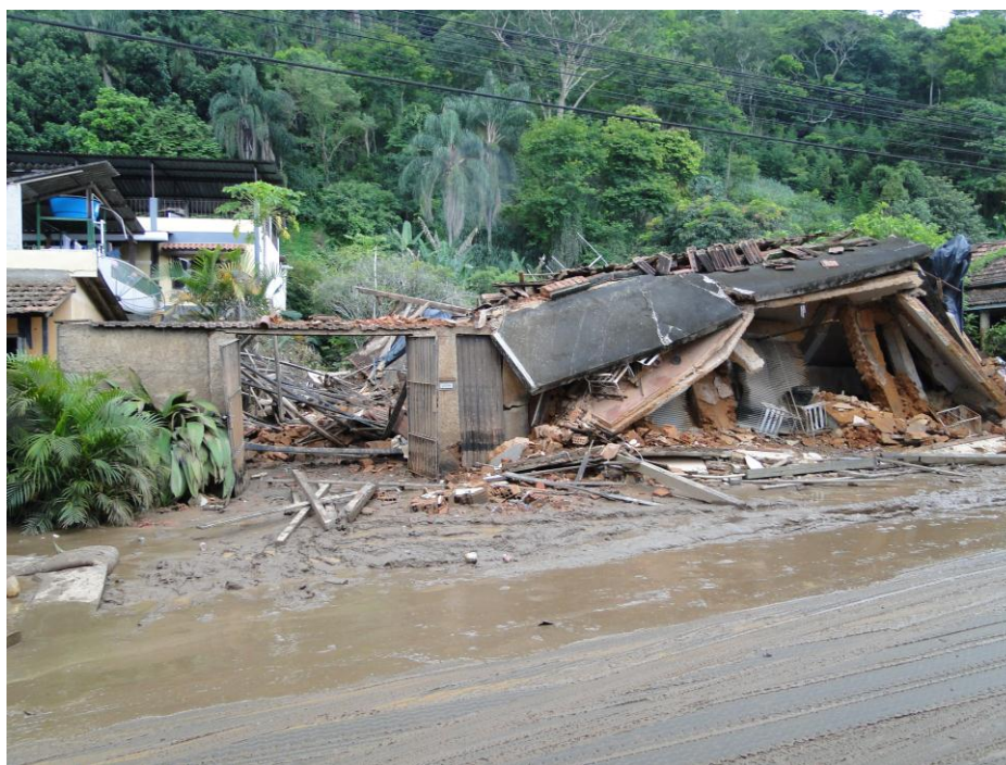
Figura 4.46 – Prédio de dois pavimentos que ruiu no Setor Afonsina. Fonte: Foto cedida pela Prefeitura Municipal de Areal, 2012.
