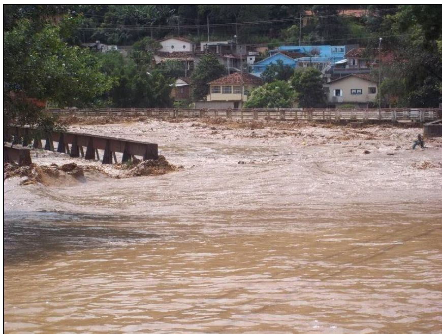
Figura 4.39 – Represamento parcial do rio por uma ponte entre os setores da Ilha e União e Indústria. Fonte: Foto cedida pela Prefeitura Municipal de Areal, 2012.
