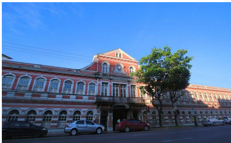
Figura 16 – Antigas instalações da Cia. Bernardo Mascarenhas - 2019
