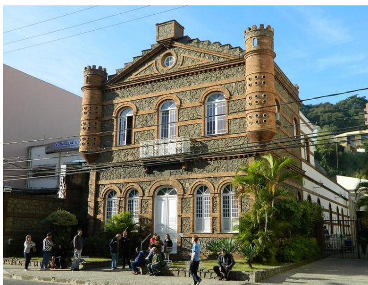
Figura 17 – Castelinho da Cemig (Cia. de Energia de Minas Gerais) - 2014
