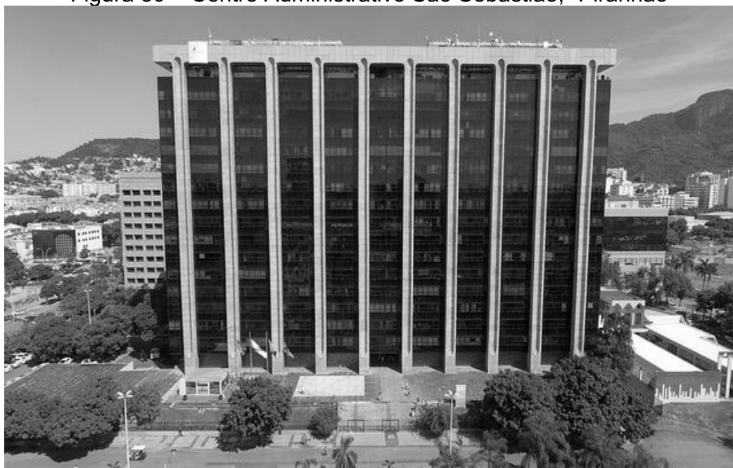
Figura 30 – Centro Administrativo São Sebastião, “Piranhão”
