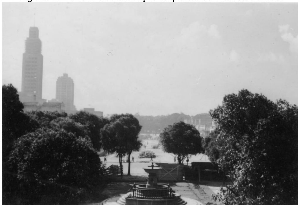
Figura 26 – Obras de construção do primeiro trecho da avenida
