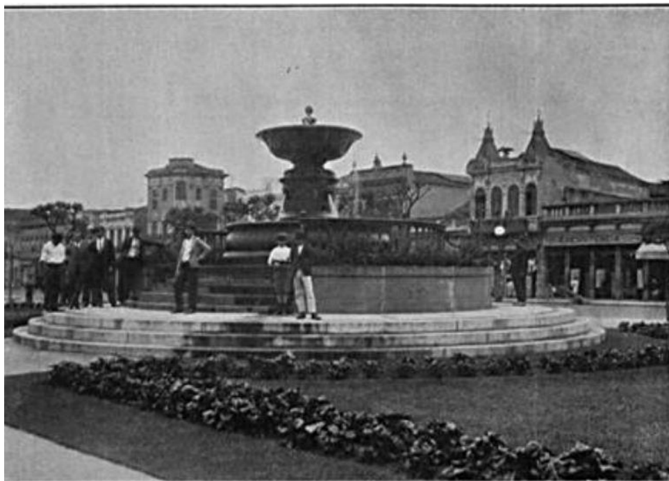
Figura 15 – Chafariz de Grandjean de Montigny no centro da Praça Onze, década de 1920
