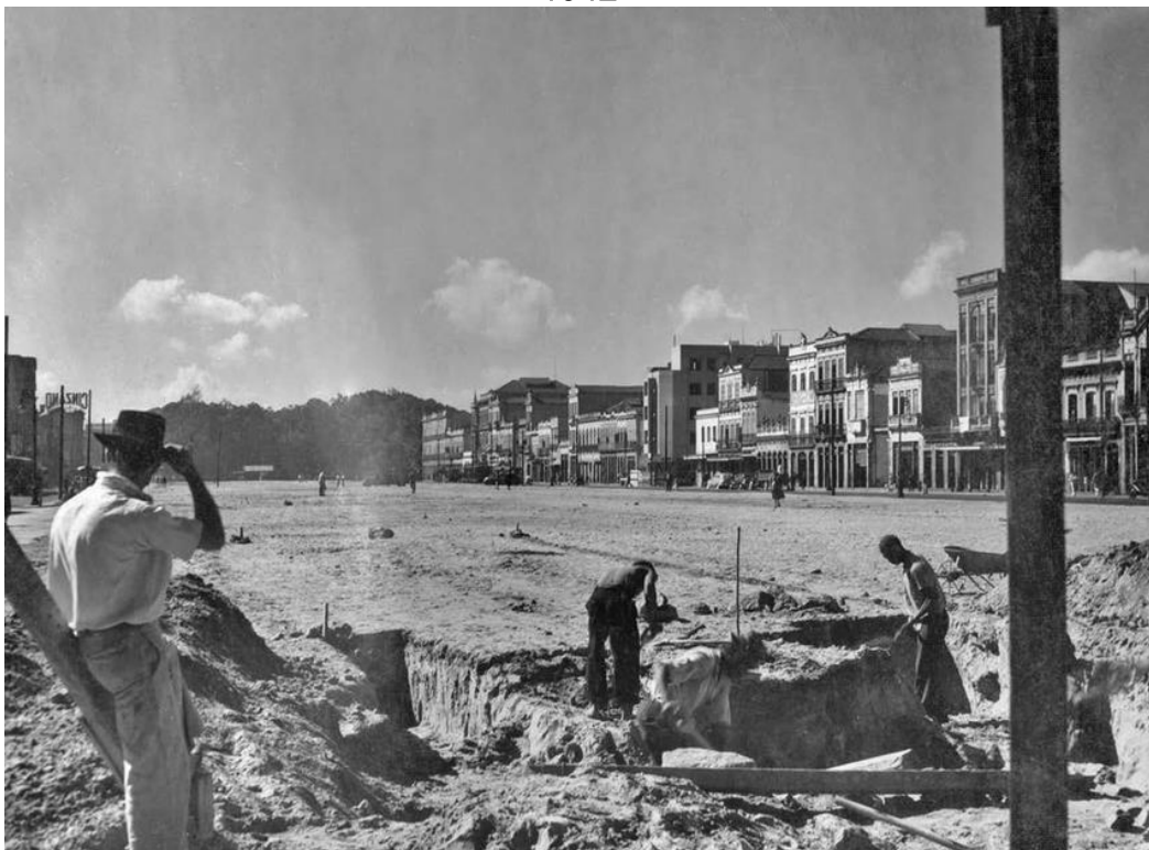
Figura 24 – Operários trabalhando na abertura da Avenida Presidente Vargas em 1942
