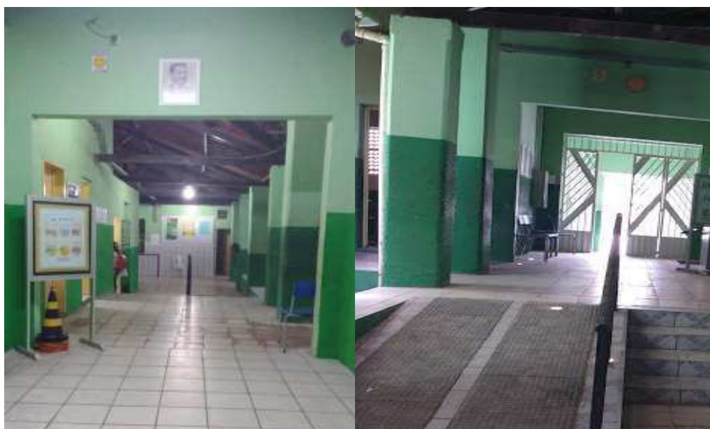
Imagem 5 – Galerias e entrada principal da escola
