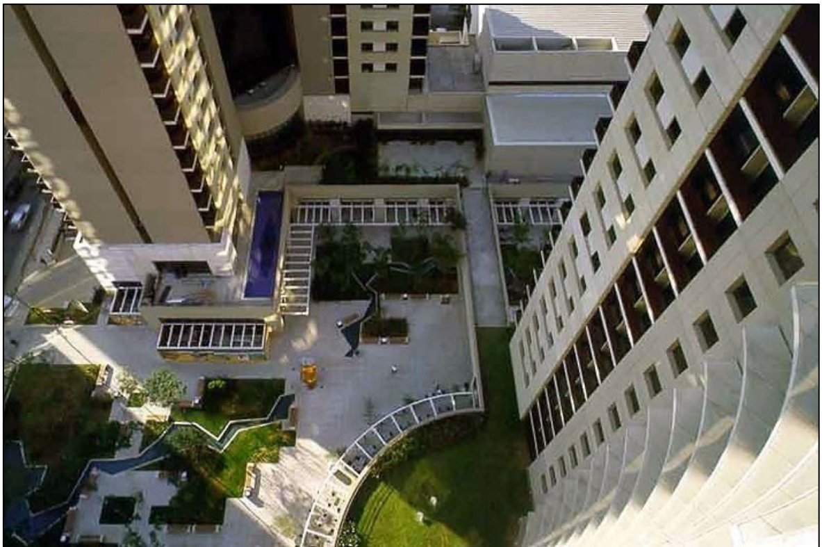
Fotografia 4 – Edifício Brascan Century Plaza
