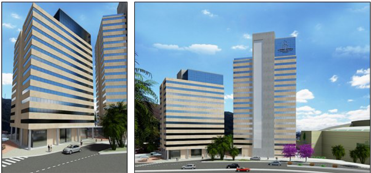
Figura 3 – Fachada do Independência Trade Hotel e Offices
