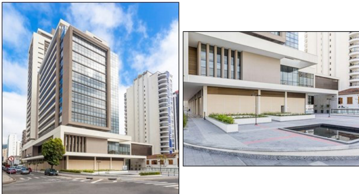
Figura 4 – Edifício Le Quartier Granbery
