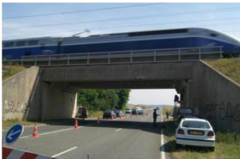
Figura 12 – Vista geral do viaduto
