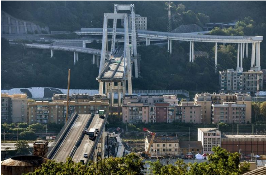
Figura 1 – Ponte Morandi em Gênova
