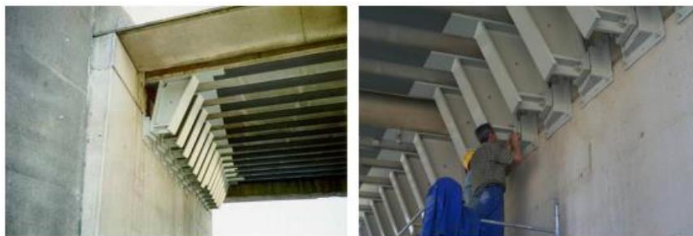
Figura 13 – Detalhes do procedimento de reforço e dos mancais
