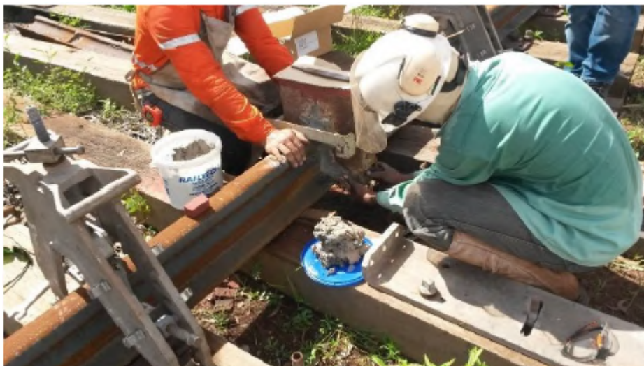
Figura 10 – Aplicação da pasta refratária nas frestas
