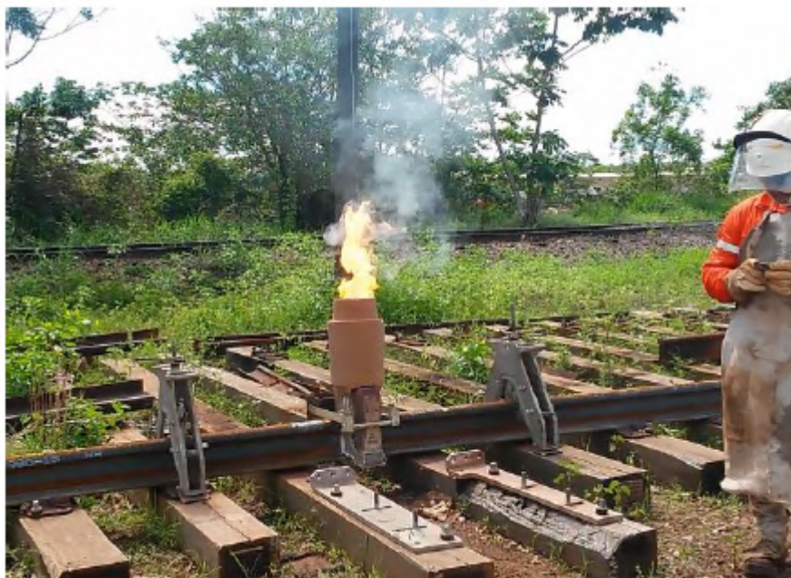
Figura 12 – Realização do processo de Soldagem Aluminotérmica
