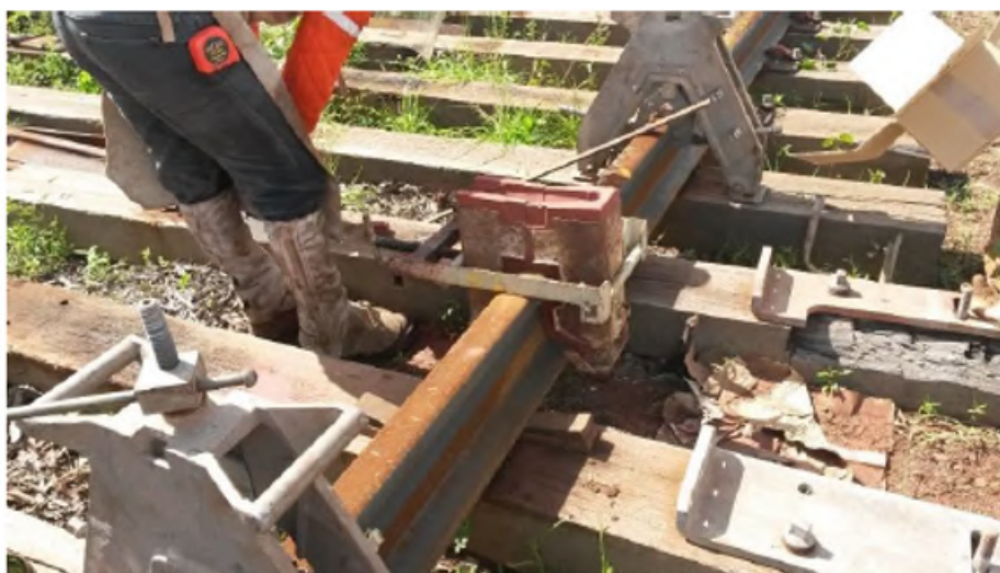
Figura 9 – Fixação do molde por cinta metálica
