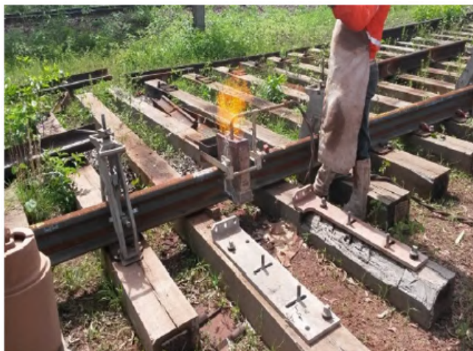
Figura 11 – Pré-aquecimento das juntas soldadas
