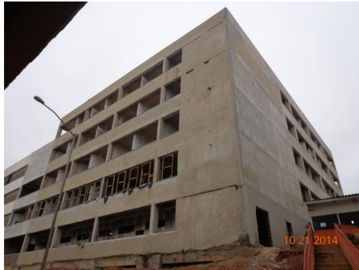
Figura 12 – Bloco E8 em construção em outubro de 2014. Fonte: AUTOR (2014).
