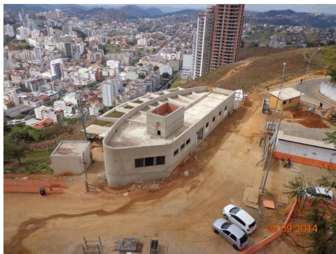
Figura 15 – Bloco H - em construção em setembro de 2014. Fonte: AUTOR (2014).
