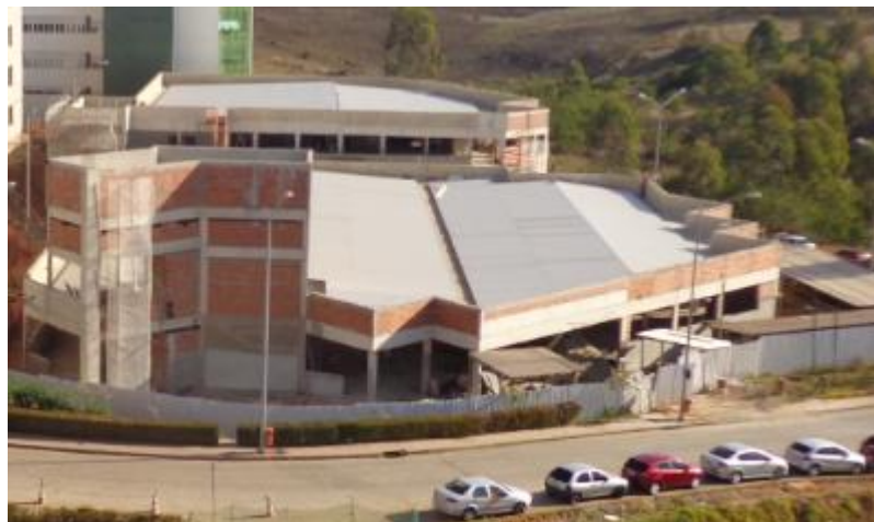
Figura 11 – Bloco E7 em construção em outubro de 2014. Fonte: AUTOR (2014).
