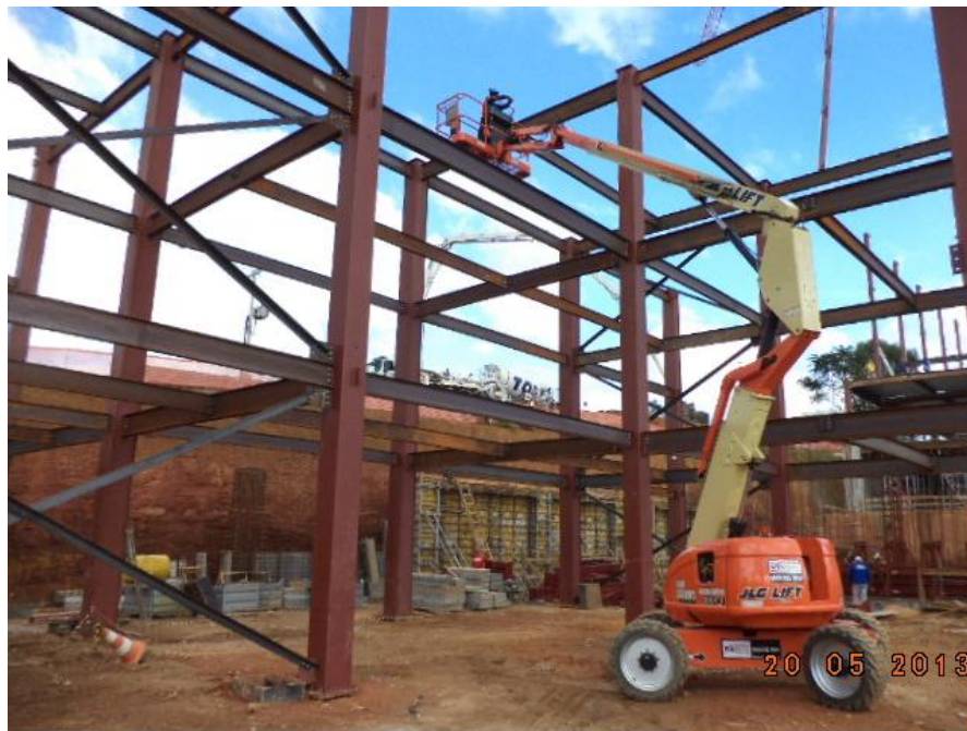
Figura 18 – Montagem de estrutura metálica. Fonte: AUTOR (2013).
