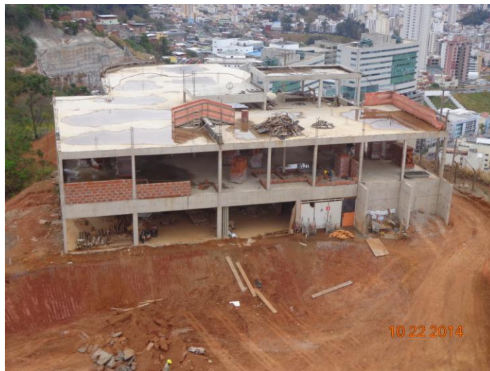
Figura 14 – Bloco F – casa de parto natural - em construção em outubro de 2014. Fonte: AUTOR (2014).
