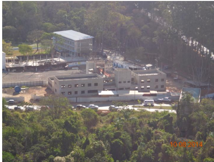
Figura 16 – Bloco G – em construção em setembro de 2014. Fonte: AUTOR (2014).
