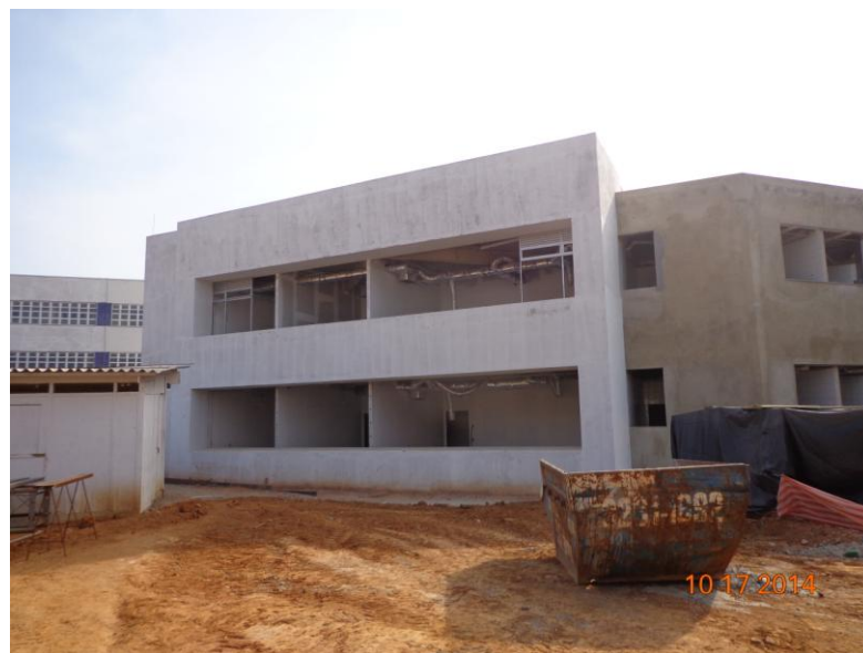
Figura 13 – Bloco E9 em construção em outubro de 2014. Fonte: AUTOR (2014).
