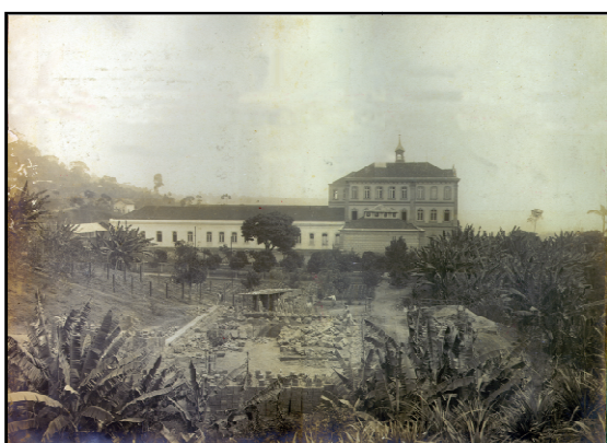
Figura 12: Início das obras do Instituto Politécnico Fonte: Acervo ACJF
