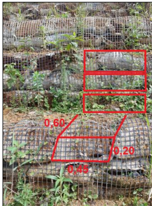
Figura 4 – Dimensões do saco de terra no talude
