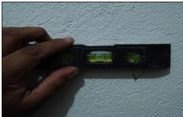
Figura 16 – Verificação dos níveis
