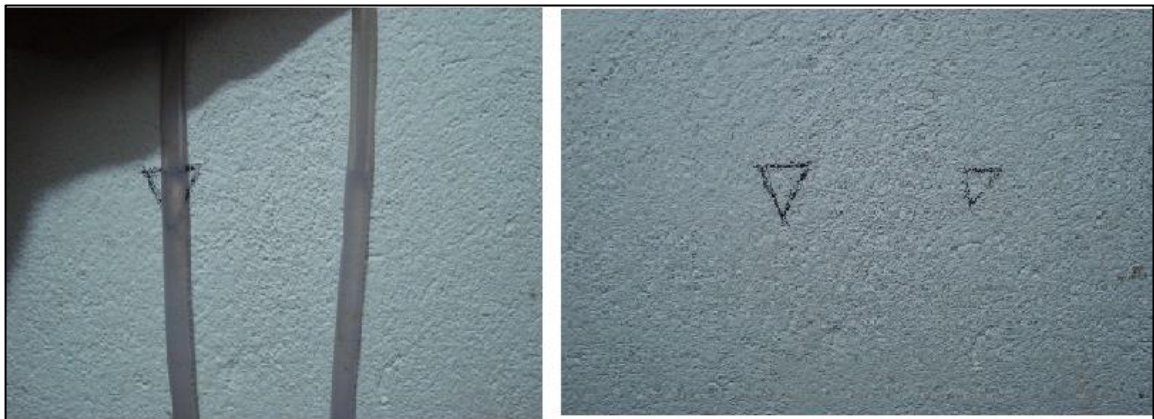
Figura 15 – Identificação do nível e marcação do nível
