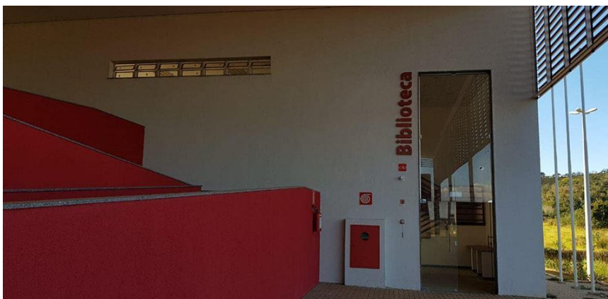
Foto 12– Entrada da Biblioteca
