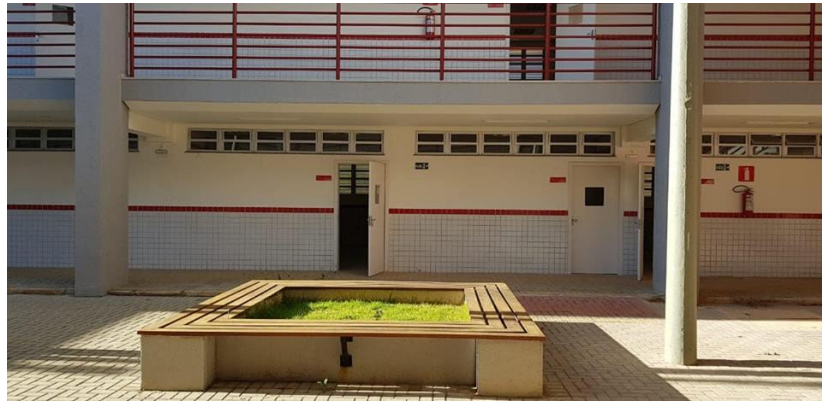
Foto 10 – Andar Térreo dos Laboratórios
