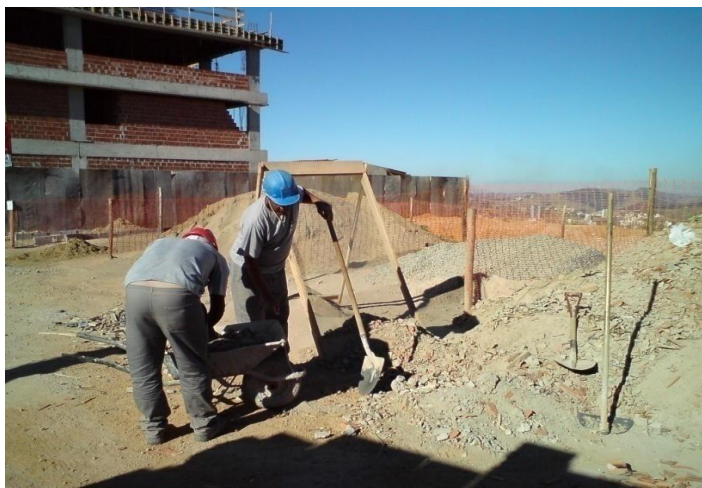
Figura 22 - Transporte Interno de resíduo com carrinho de mão para baia de acondicionamento.
