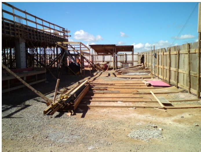
Figura 27 - Frente da obra após a implantação do Programa de Gestão de Resíduos.
