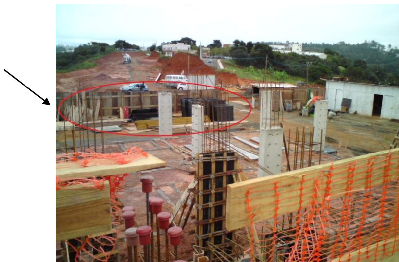
Figura 26 - Materiais e equipamentos dispostos à frente da obra antes da implantação do Programa de Gestão de Resíduos.
