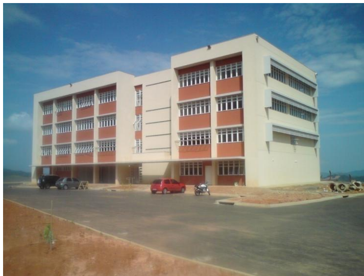
Figura 9 - Vistas frontal e lateral do edifício da nova Faculdade de Economia da UFJF.
