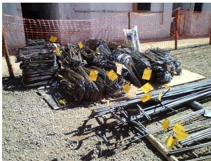
Figura 17 - Depósito de barras de aço fornecidas cortadas e dobradas.
