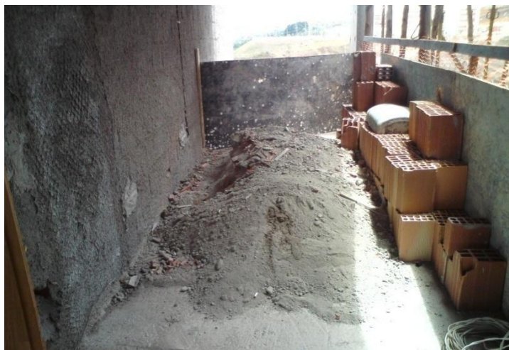
Figura 30 - Volume de resíduo de argamassa acondicionado após limpeza de um pavimento do edifício.
