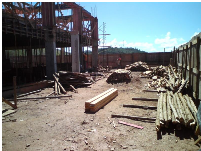
Figura 29 - Madeira proveniente da desforma da estrutura disposta de forma regular.
