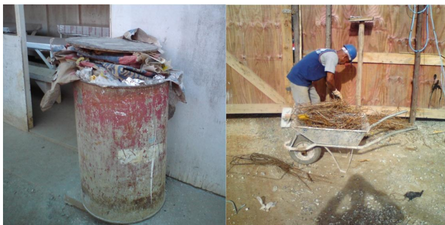
Figura 18 - Quantificação de papel e aço através de tambor metálico e carrinho de mão.
