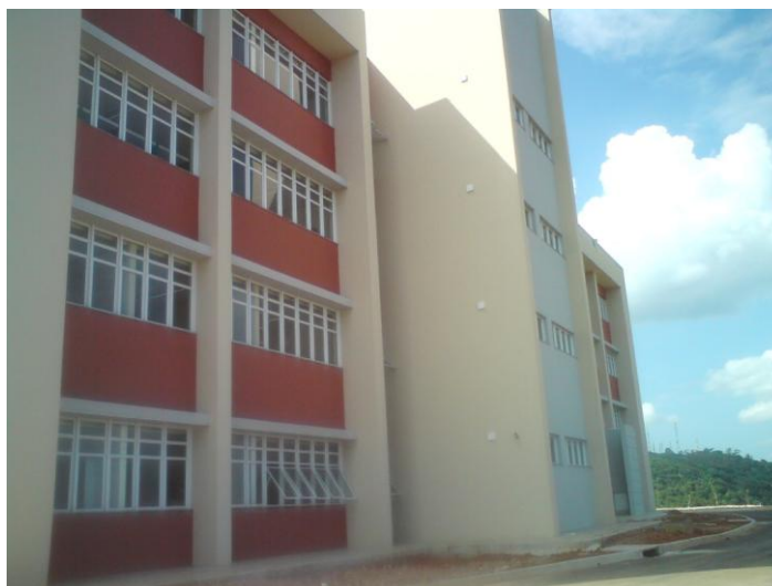
Figura 10 - Vista posterior do edifício da nova Faculdade de Economia da UFJF.
