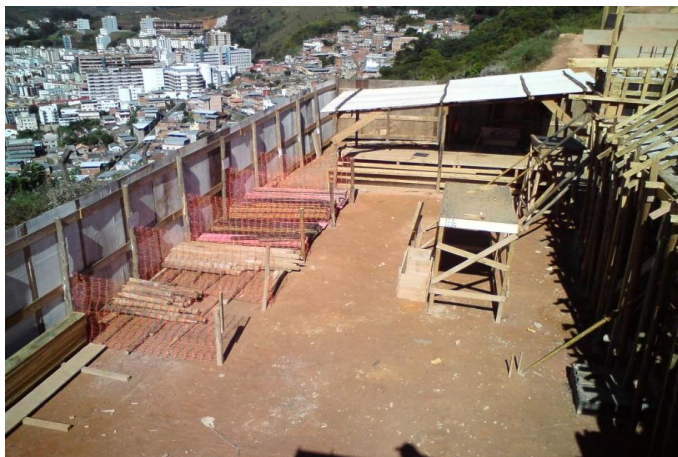
Figura 21 - Baias para acondicionamento de madeira a ser reutilizada na obra.
