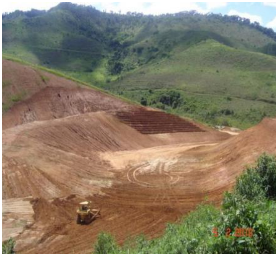
Figura 25 – Aterro Sanitário de Juiz de Fora (CTR), área de aterro de inertes.
