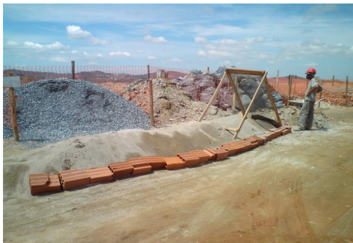
Figura 24 - Operário peneirando resíduo de argamassa, concreto e tijolo para obter areia reciclada.
