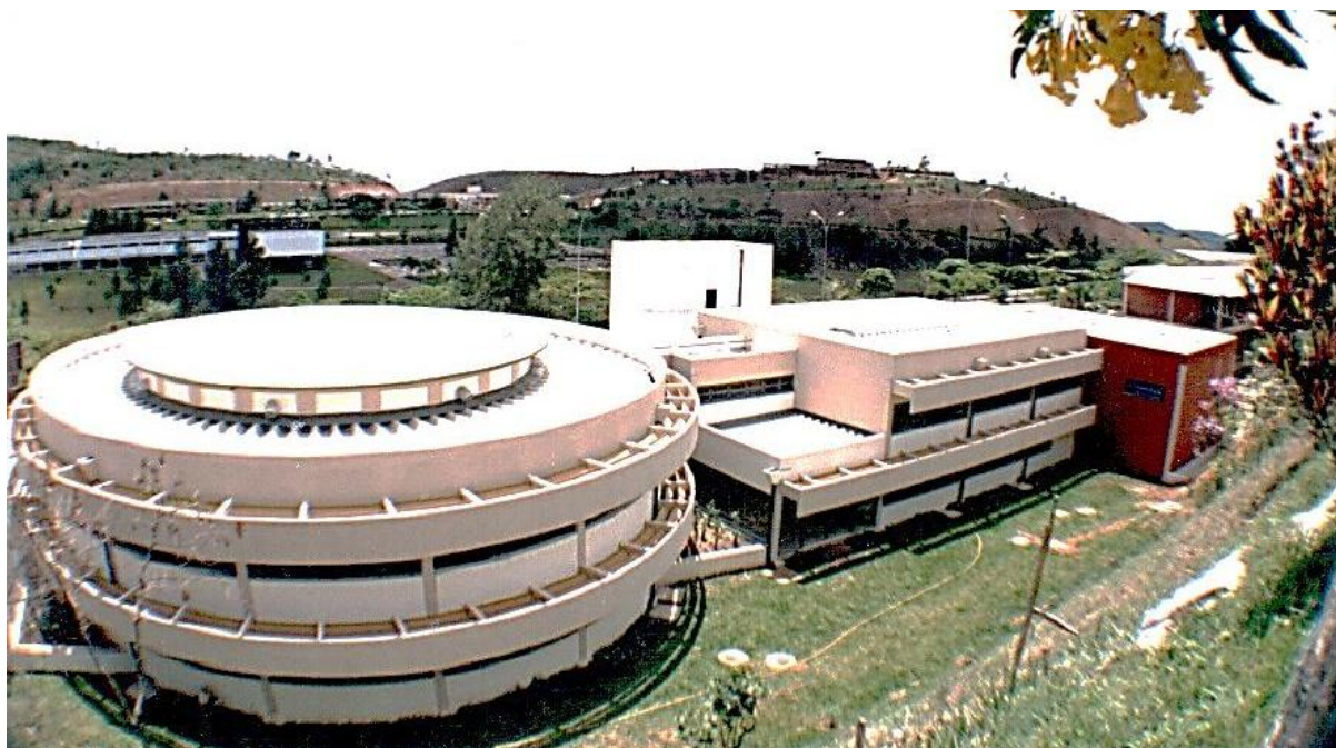
Figura 22 – Centro de Línguas da UFJF – Autoria: Arquiteto Cláudio Mafra Mosqueira. Fonte: Acervo da Pró-Reitoria de Infraestrutura/ UFJF
