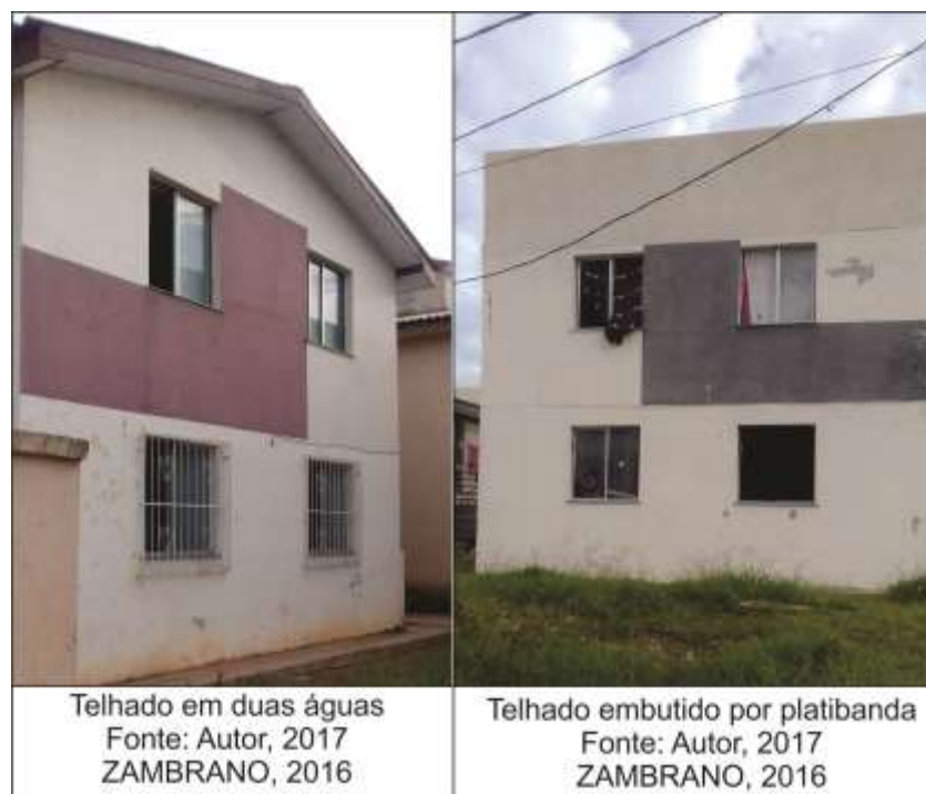
Figura 36 - Cobertura dos Sobrados: Residencial Miguel Marinho
