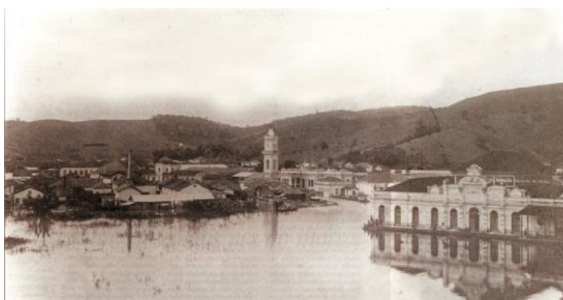
Figura 59: Inundação do Paraibuna em 1906. Fonte: < http://mariadoresguardo.blogspot.com.br >
