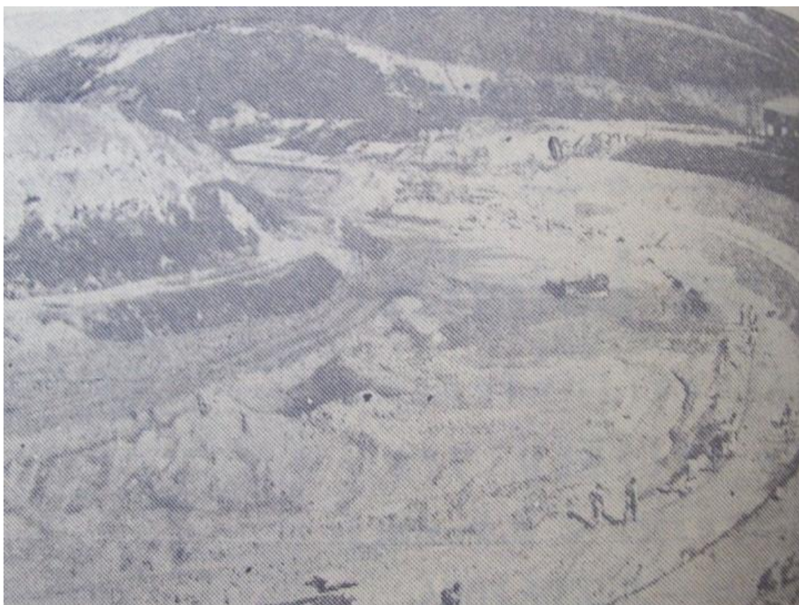
Figura 34: Canal Howian em construção. Fonte: (O SENTIDO ... 1950).
