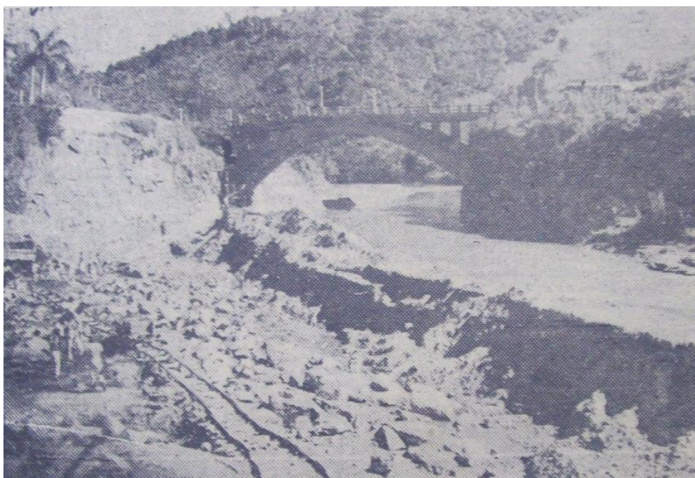
Figura 51: Serviço de derrocamento na ponte Getúlio Vargas. Fonte: (O SENTIDO ...1950).
