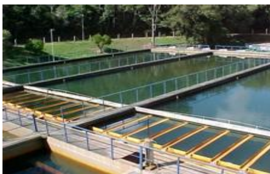
Figura 14: Estação de tratamento de água Dr. João Penido.
