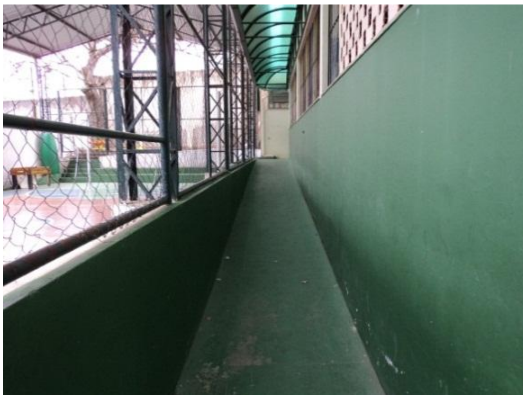
Figura 20 - Exemplo de rampa de acesso no pátio
