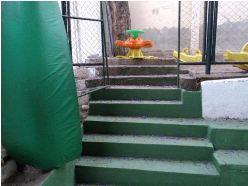
Figura 21 - Escola sem rampa de acesso para a área de playground
