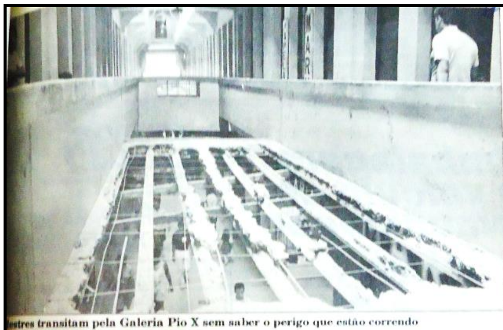
Figura 67: Laje da Galeria exposta durante obras
