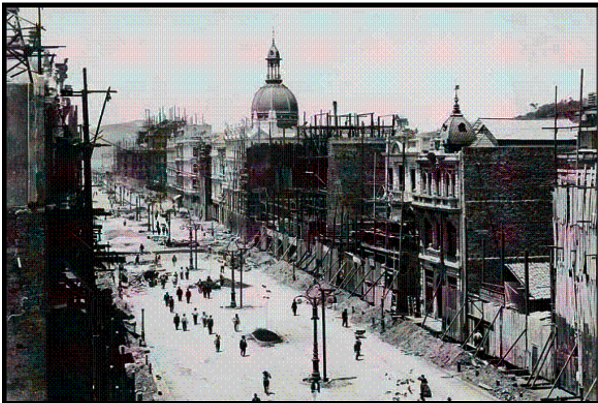
Figura 20: Abertura da Av. Central e remodelação de fachada
