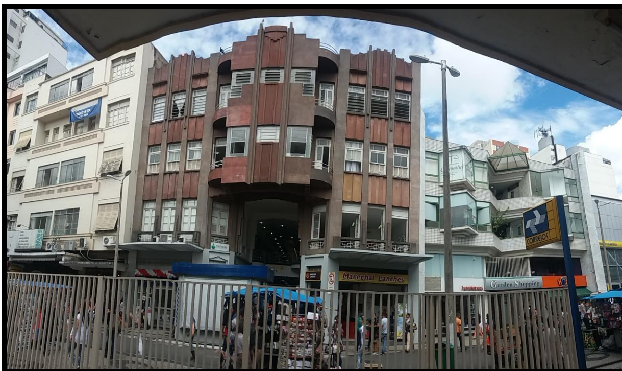
Figura 6: Fachada Rua Marechal Deodoro
