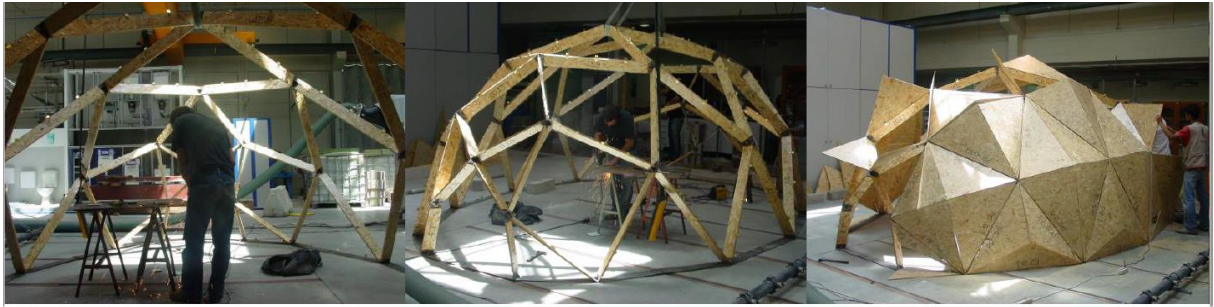
Figura 19 - Montagem do Pavilhão Tetra Script
