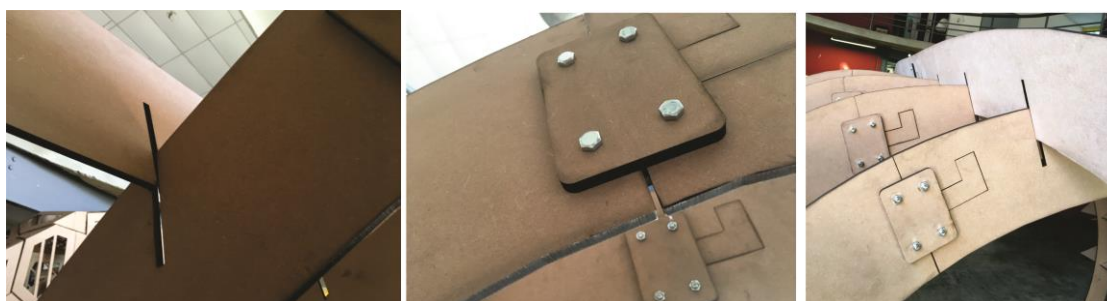
Figura 75 – Imperfeições causadas pela tolerância mínima dos entalhes.
