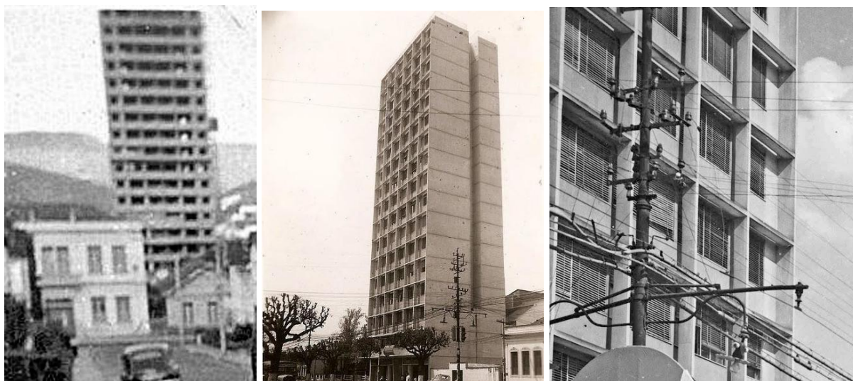
Figura 85 – Detalhe da fachada do edifício Excelsior.
